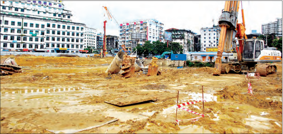
မင်္ဂလာဈေးသစ်တည်ဆောက်ရန် လုပ်ငန်းများစတင်နေမှုကို တွေ့ရစဉ်။
