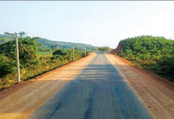
မွန်ပြည်နယ်ရှိ ဘီးလင်း-နတ်ကြီး-ဖာပွန်လမ်း ဆောင်ရွက်ပြီးစီးမှုကို တွေ့ရစဉ်
