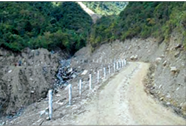
ကလေး-ဖလမ်း-ဟားခါးလမ်း ပြုပြင်ဆောင်ရွက်ထားမှုကို တွေ့ရစဉ်
