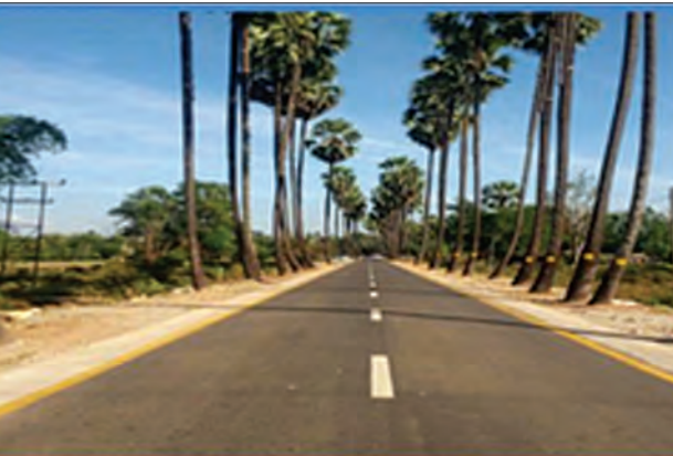
မွန်ပြည်နယ်ရှိ မော်လမြိုင်-ကျိုက်မရောလမ်းလုပ်ငန်းဆောင်ရွက်ပြီးစီးမှုကို တွေ့ရစဉ်
