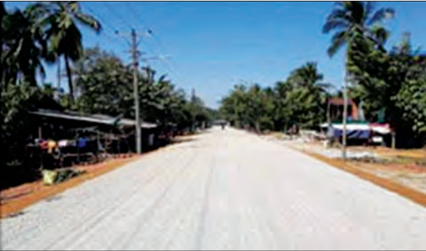
ရေးမြို့အဝင်လမ်း လုပ်ငန်းဆောင်ရွက်ပြီးစီးမှုကို တွေ့ရစဉ်
