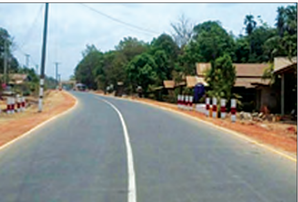
အိန္ဒြာ-ဇာသပြင်လမ်း ကတ္တရာကွန်ကရစ်ခင်းခြင်းလုပ်ငန်းဆောင်ရွက်ပြီးစီးမှုကိုတွေ့ရစဉ်
