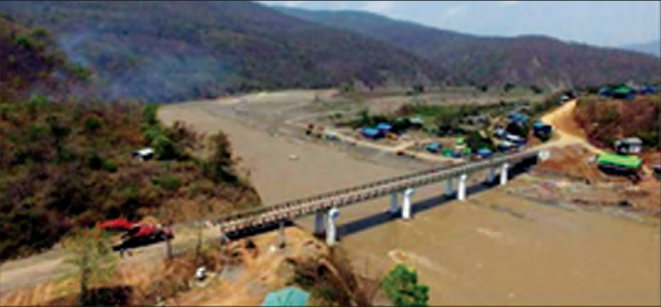
တီးတိန်-တွန်းဇံ-ကျီခါးလမ်းပေါ်ရှိ နတ်ဇံတံတားလုပ်ငန်းဆောင်ရွက်ပြီးစီးမှုကို တွေ့ရစဉ်
