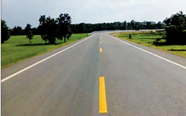
ကော့ကရိတ်-မြဝတီလမ်း လုပ်ငန်းဆောင်ရွက်ပြီးစီးမှုကို တွေ့ရစဉ်
