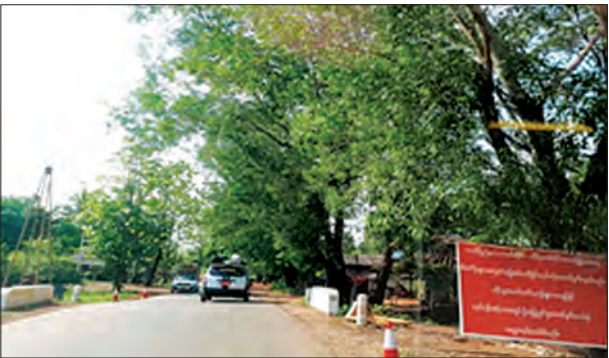
အိန္ဒြာ-ကော့ကရိတ်လမ်း လုပ်ငန်းဆောင်ရွက်ပြီးစီးမှုကို တွေ့ရစဉ်
