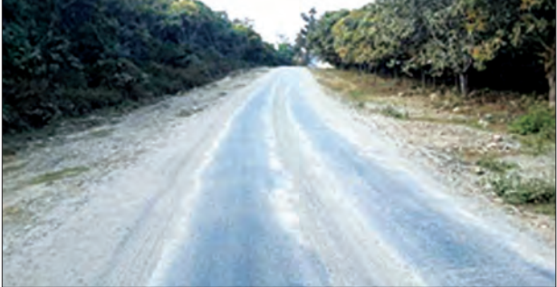
ကျောက်တော်-ပလက်ဝလမ်း မိုင် ၃၃/၄-၃၃/၅ ကီလိုမီတာ(၅၃.၆-၅၃.၈)ကြား ကတ္တရာလမ်းခင်းခြင်းလုပ်ငန်း ဆောင်ရွက်ပြီးစီးမှုကို တွေ့ရစဉ်
