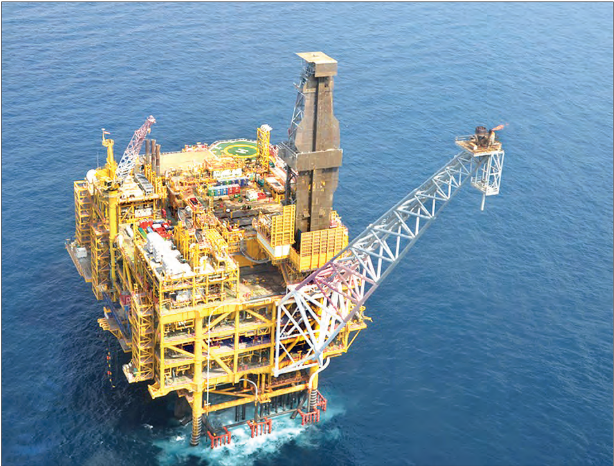
ရွှေကမ်းလွန်သဘာဝဓာတ်ငွေ့စီမံကိန်းမှ သဘာဝဓာတ်ငွေ့ထွက်ရှိနေမှုကို တွေ့ရစဉ်။ (သတင်း - စာ-၄) သတင်းစဉ်
