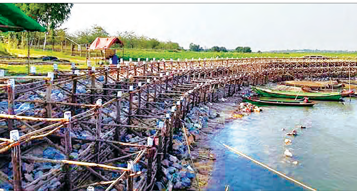
ပြုကျောက်စီခြင်း၊ Steel Basket အခြေပြုကျောက်စီခြင်း၊ ကျောက်ဖြည့် မျောဂရစ်တန်၊ မျောတိုင်တန်းကျောက် ဖြည့်ရေကာစသည့် နည်းလမ်းများ အသုံးပြုကြောင်း သိရသည်။ ကမ်းပြိုရသည့် အကြောင်းအရင်း များမှာ လူသားတို့ အပြုအမူကြောင့် သစ်တောပြုန်းတီးရာမှ မြေဆီလွှာများ မြစ်ထဲရောက်ရှိကာ အနည်အနှစ်ကျခြင်း၊ မူကြောင့် ထူးခြားမြစ်ရေတက်ခြင်းတို့က မြစ်၏ရေဝေရေလဲဒေသများတွင် စည်း ကမ်းပြိုမှုဖြစ်ကြောင်း သိရသည်။ မင်းထက်အောင်(မန်းကိုယ်ပွား)
