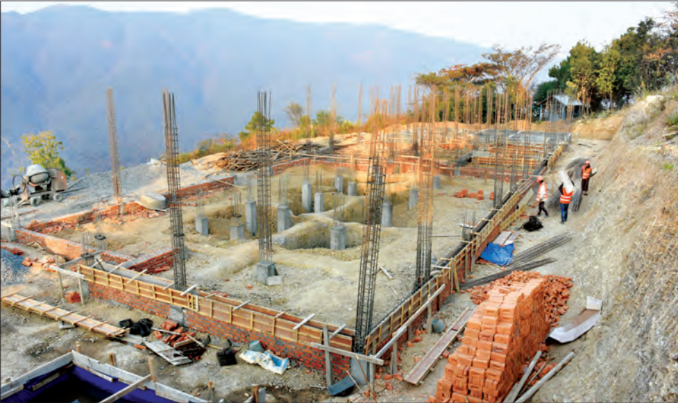
ဒုတိယသမ္မတ ဦးဟင်နရီဗန်ထီးယူနှင့်အဖွဲ့ ထန်တလန်မြို့ ပြည်သူ့ဆေးရုံ၌ ဝန်ထမ်းအိမ်ရာတည်ဆောက်နေမှုကို ကြည့်ရှုစစ်ဆေးစဉ်။
