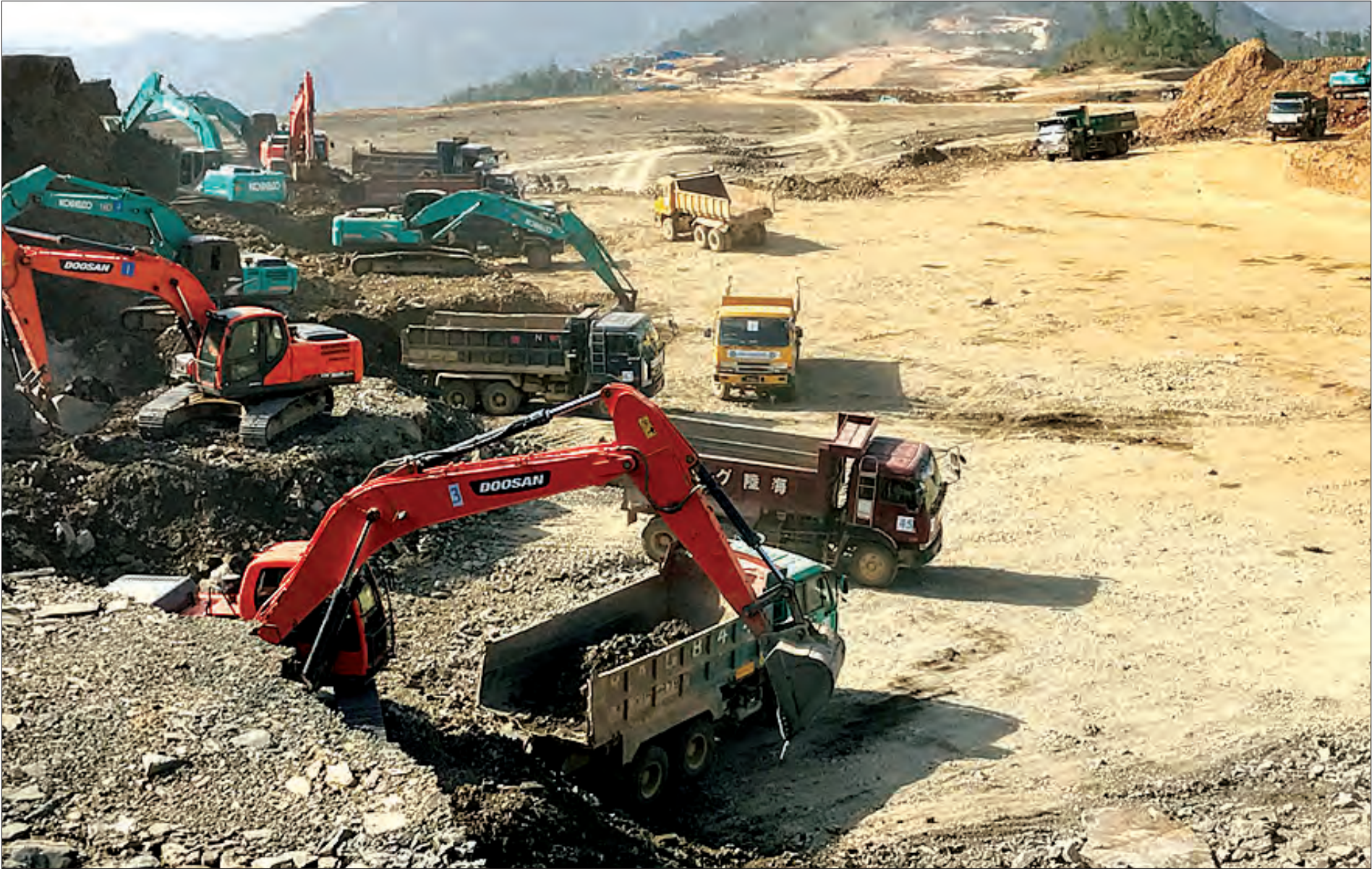
ချင်းပြည်နယ် ဗလမ်းမြို့၊ လေဆိပ်တည်ဆောက်ရေးစီမံကိန်းလုပ်ငန်းခွင်ကို တွေ့ရစဉ်။
