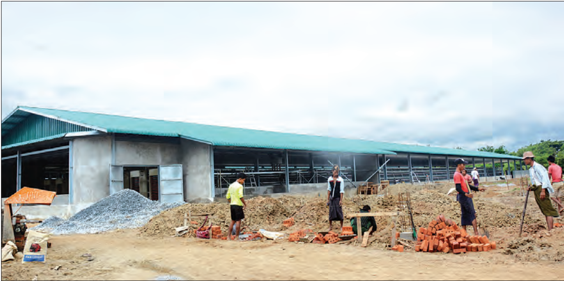
ခေတ်မီဥစားကြက်ခြံဆောက်လုပ်နေမှုကို တွေ့ရစဉ်။
