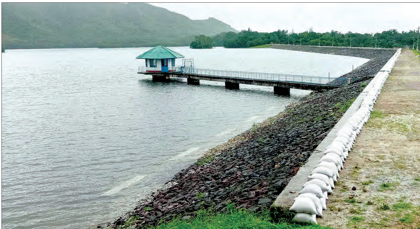
ရွှေနတ်တောင် ရေလျှောင်တံမံအတွင်း ရေများဝင်ရောက်နေမှုကို တွေ့ရစဉ်။
