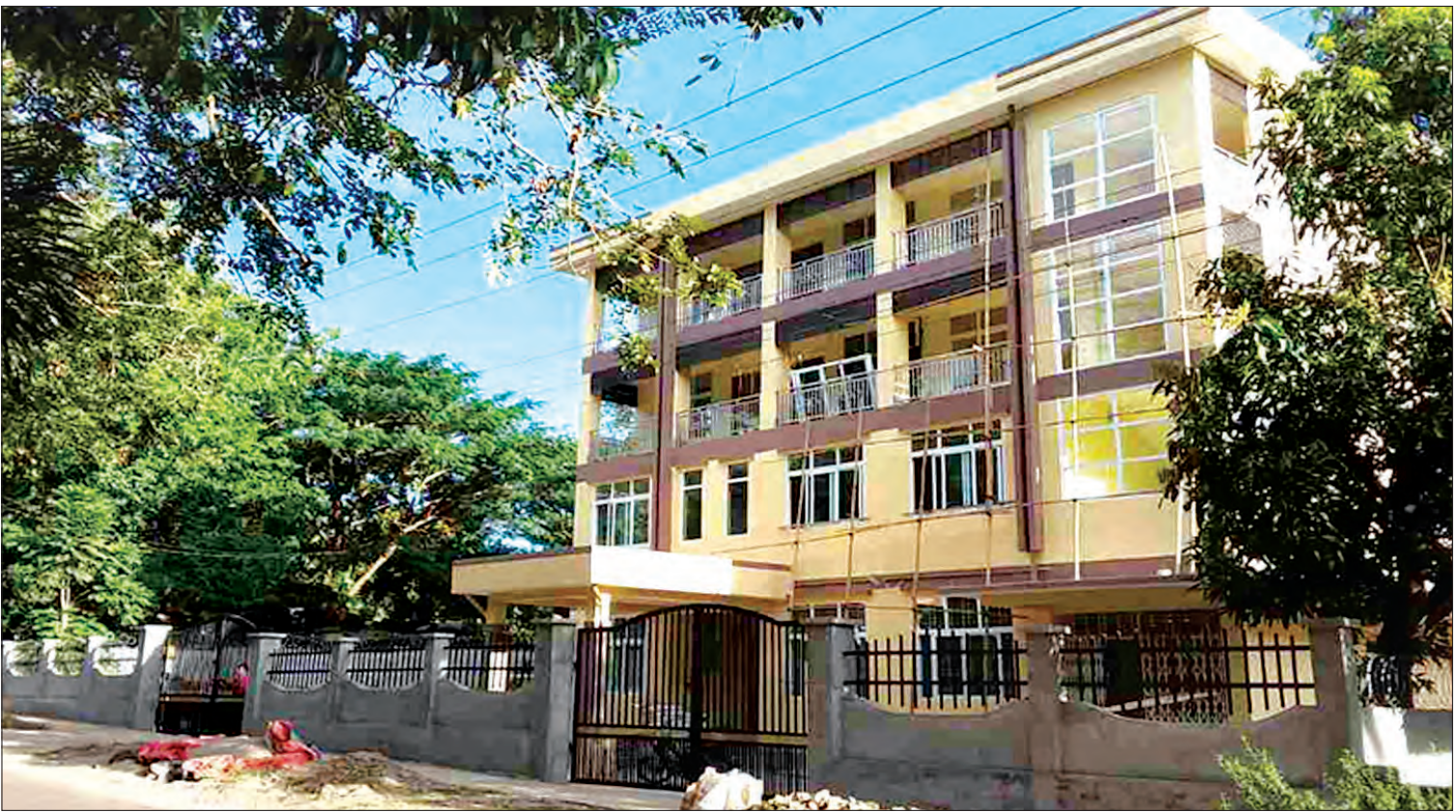
သထုံခရိုင် ပြည်သူ့ကျန်းမာရေးဦးစီးမှူးရုံး လေးထပ်အဆောက်အအုံဆောက်လုပ်နေမှုကို တွေ့ရစဉ်။
