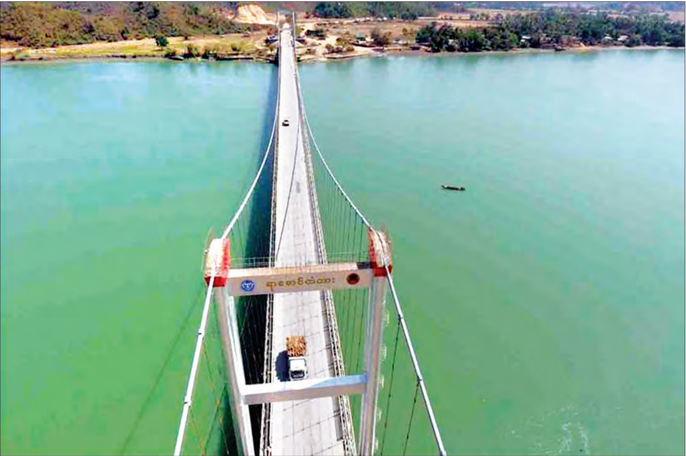
ရန်ကုန်-စစ်တွေလမ်း ရာမောင်ကြိုးတံတား၊ အကြီးစားပြုပြင်ထိန်းသိမ်းဆောင်ရွက်ထားမှုကို တွေ့ရစဉ်
