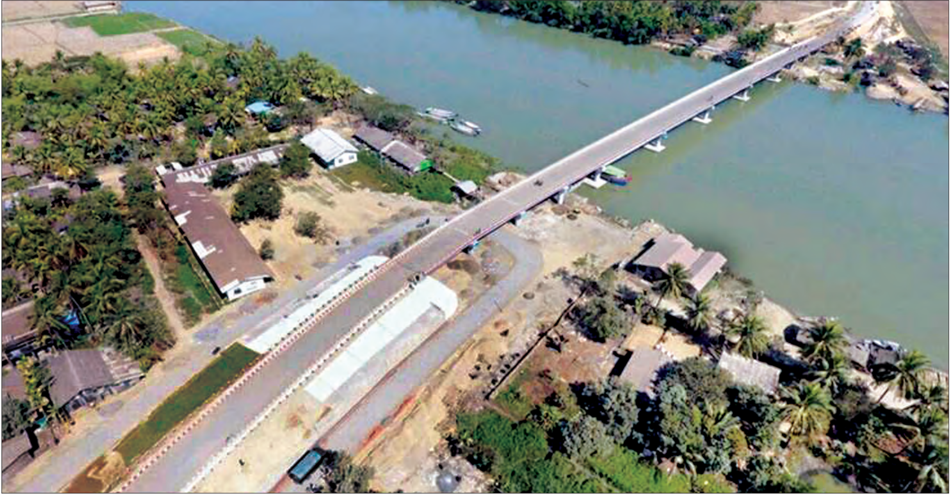
ရသေ့တောင်-ဘူးသီးတောင်လမ်း ပန်ဇင်းချောင်းတံတား (293m)အရှည် သံကူကွန်ကရစ်တံတား တည်ဆောက်ပြီးစီးမှုအခြေအနေကို တွေ့ရစဉ်
