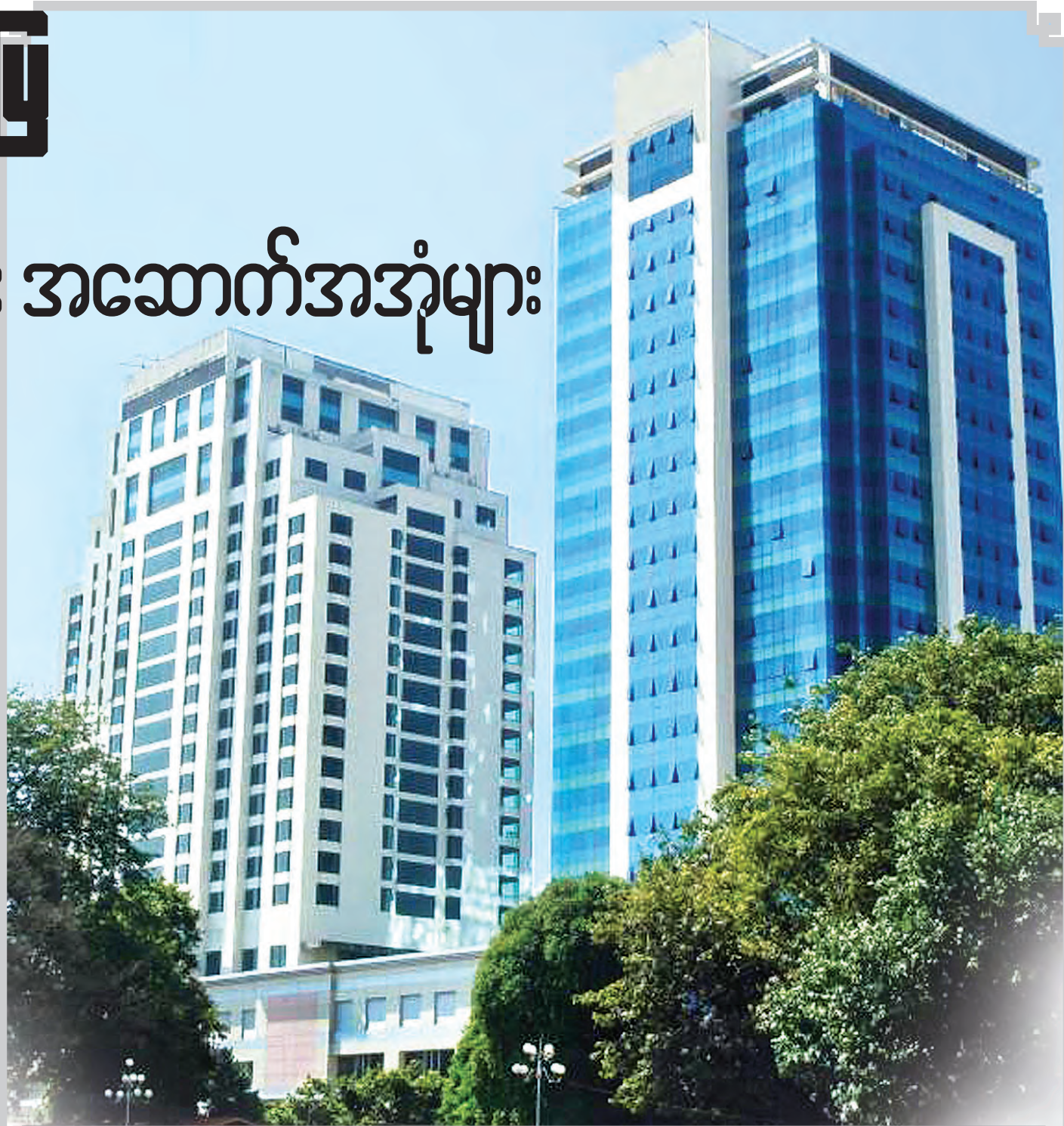
ရန်ကုန်မြို့၏ ပဉ္စမအမြင့်ဆုံး အဆောက်အအုံ Centre Point Tower
