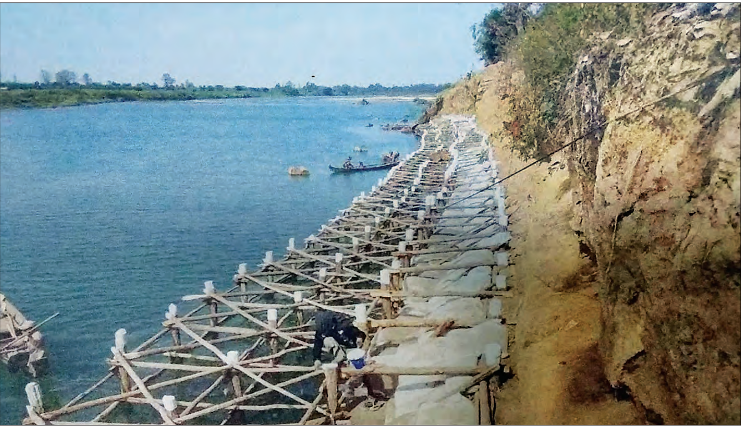
မကွေးတိုင်းဒေသကြီးတွင် ၂၀၁၇-၂၀၁၈ ဘဏ္ဍာရေးနှစ်အတွင်း ငွေလုံးငွေရင်းဖြင့် ဆောင်ရွက်လျက်ရှိသော ကမ်းပြိုထိန်းသိမ်းရေးလုပ်ငန်း ဆောင်ရွက်မှုကို တွေ့ရစဉ်။
