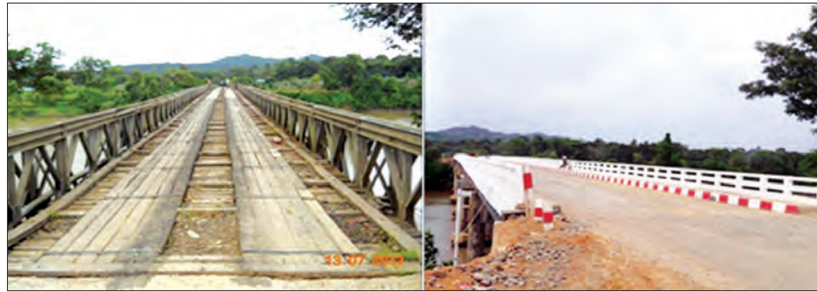
ရန်ကုန်-ကျောက်ဖြူလမ်း (တောင်ကုတ်-မအီ အပိုင်း) မူလ ဘေလီ+သစ်သားတံတားမှ သံကူကွန်ကရစ်တံတားသို့ အဆင့်မြှင့်တင် ဆောင်ရွက်သည့် အရှည်ပေ ၆၀၀ ရှိ တန်းလွှဲတံတားအား မဆောင်ရွက်မီပုံနှင့် ဆောင်ရွက်ပြီးပုံ
