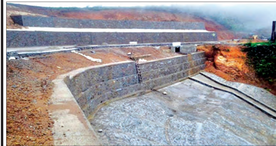
မင်းဘူး-အမ်း-စစ်တွေလမ်း ပေါ်ရှိ (၁၀၉ ဒဿမ ၅ ကီလိုမီတာ-၁၁၀ ကီလိုမီတာ)အတွင်း ကျောက်စီမြေထိန်းနံရံ တည်ဆောက် ခြင်းလုပ်ငန်း ဆောင်ရွက်ပြီးစီးမှုကို တွေ့ရစဉ်
