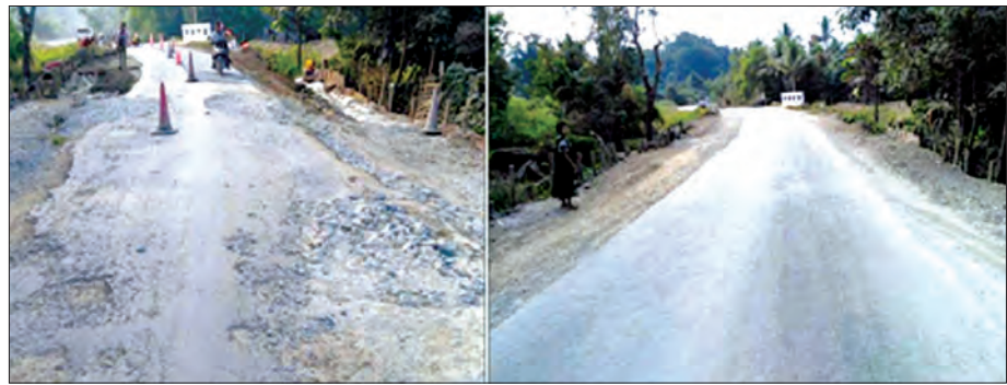
သံတွဲ-ဂွလမ်း (၁ ဒဿမ ၈ ကီလိုမီတာ-၉ ကီလိုမီတာ)အတွင်း ကတ္တရာထပ်ပိုးလွှာခင်းခြင်းလုပ်ငန်း မဆောင်ရွက်မီပုံနှင့် ဆောင်ရွက်ပြီးစီးပြီးနောက် တွေ့ရပုံ
