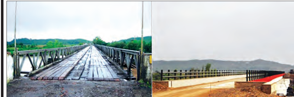
မင်းဘူး-အမ်း-စစ်တွေလမ်း မူလဘေလီ+သစ်သားတံတားမှ သံကူကွန်ကရစ်တံတားသို့ အဆင့်မြှင့်တင်ဆောင်ရွက်သည့် ကင်းချောင်းတံတား အရှည်ပေ ၄၄၀ အား မဆောင်ရွက်မီပုံနှင့် ဆောင်ရွက်ပြီးနောက် တွေ့ရပုံ
