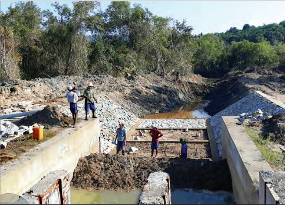
မြို့နယ်ဆည်မြောင်းဦးစီးဌာန၏ တာတမံနှင့် ရေထွက်ပေါက် သုံးခု ပေါက်တစ်ခု တည်ဆောက်ပေးရန် ၂၀၁၈ - ၂၀၁၉ ဘဏ္ဍာရေးနှစ်အတွင်း ဖောက်လုပ်ရန်နှင့် ကော့လိုင်ဒေပန္န ရှိကြောင်း သိရသည်။
