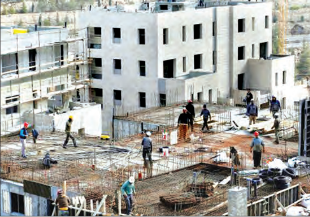
အစွဲရေးရှိ ဆောက်လုပ်ရေးလုပ်ငန်းခွင်တစ်ခုကို တွေ့ရစဉ်
