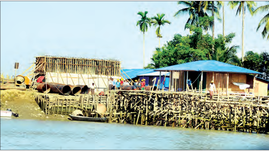
ပုဏ္ဏားကျွန်း- ရသေ့တောင်- ဘူးသီးတောင် လမ်းကြောင်းပေါ်၌ တည်ဆောက်လျက်ရှိသော စိုင်းဒင်တံတား တည်ဆောက်နေမှုကို တွေ့ရစဉ်။
