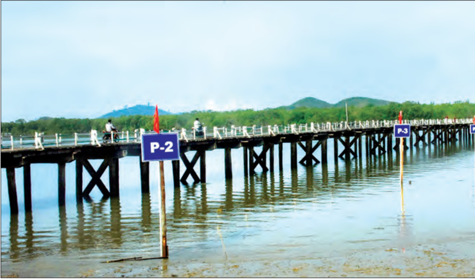
ဒုတိယသမ္မတ ဦးဟင်နရီဗန်ထီးယူ ပုလုံးတုံးတုံးတံတားတည်ဆောက်ရေးစီမံကိန်းကို ကြည့်ရှုစစ်ဆေးစဉ်။
