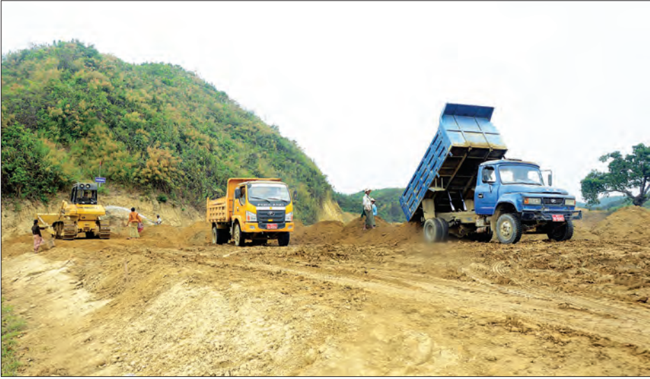
မောင်တောမြို့နယ် ကိုင်းကြီးတစ်ဖက်ပိတ်ဆည်ကို စက်ယန္တရားများအသုံးပြု၍ ဆောင်ရွက်နေသည်ကို တွေ့ရစဉ်။
