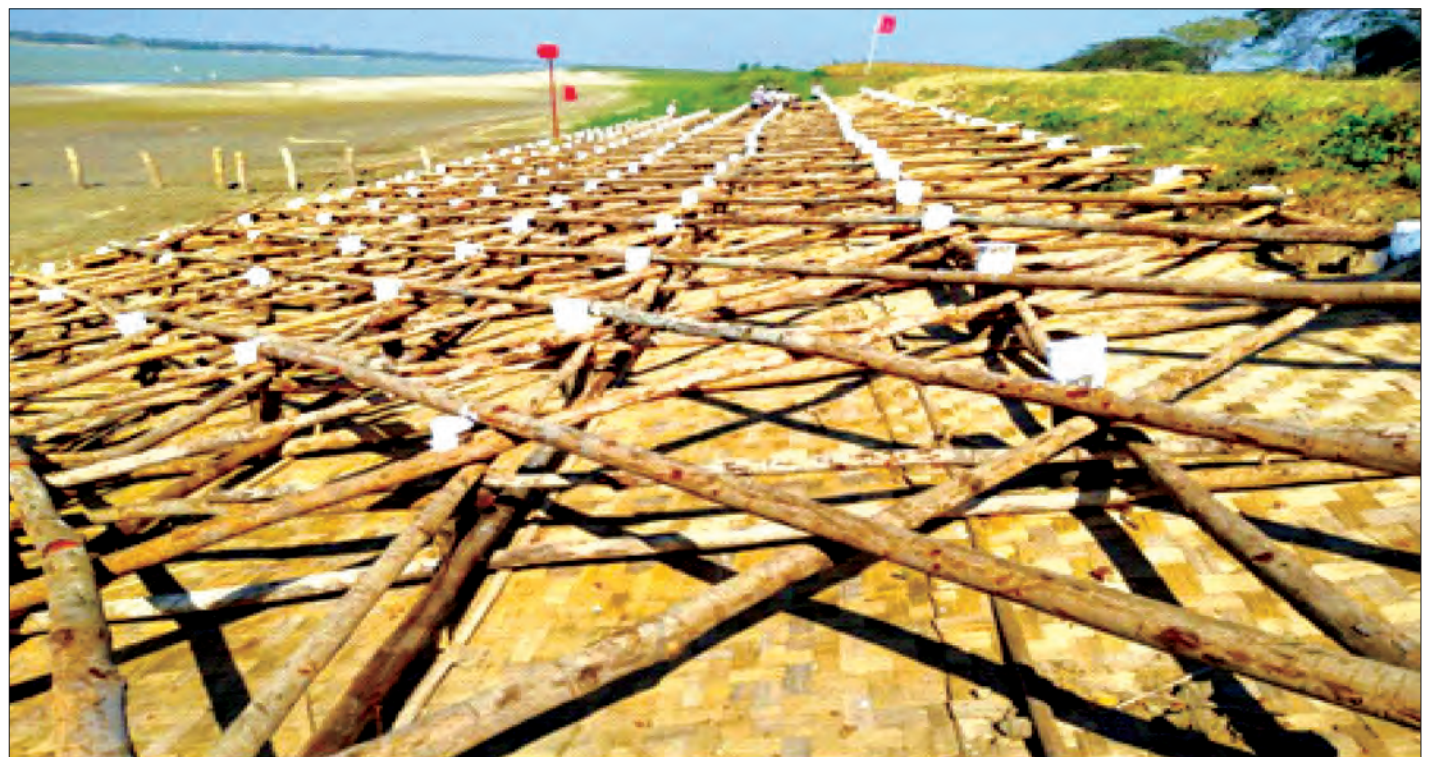
ကမ်းပြိုကာကွယ်ရေးလုပ်ငန်းအတွက် အခြေထိန်းရေမျောရေတား ဝါးထရံခင်းဆောင်ရွက်ထားမှုကို တွေ့ရစဉ်
