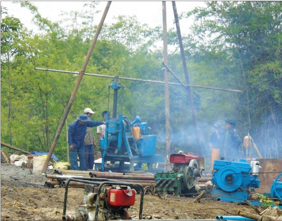
သင်ပေါင်းဒေသတွင် ကျောက်မီးသွေးရှာဖွေရေးလုပ်ငန်းဆောင်ရွက်ရန် လွန်တူးလုပ်ငန်းဆောင်ရွက်နေစဉ်။
