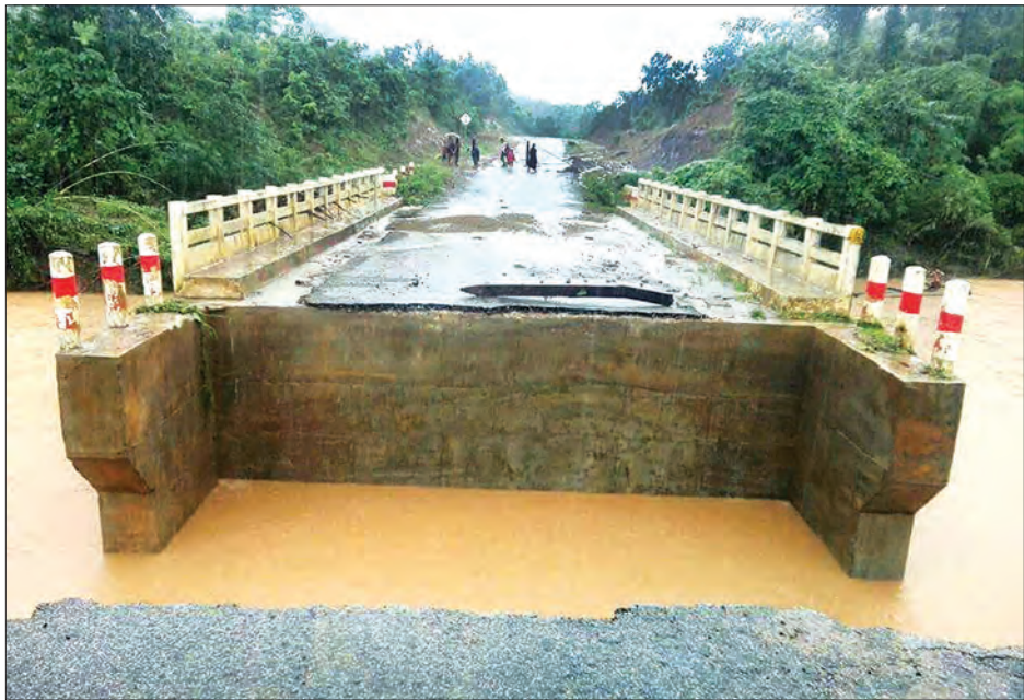
လှိုင်းဘွဲ့-ရှမ်းရွာသစ်လမ်းပေါ်ရှိတံတားတစ်စင်း တောင်ကျရေတိုက်စားမှုကြောင့် တံတားချဉ်းကပ်လမ်းပျက်စီးမှုကို တွေ့ရစဉ်။ ဓာတ်ပုံ-ရှမ်းရွာသစ်(ပြန်/ဆက်)
