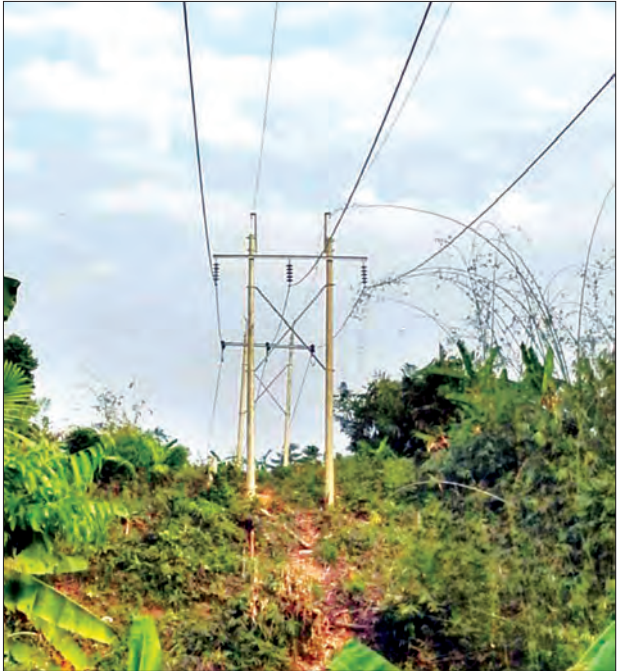
၆၆ ကေပွီ မိုးကောင်း-ဖားကန့် ဓာတ်အားလိုင်း တည်ဆောက်ပြီးစီးမှုကို တွေ့ရစဉ်။
