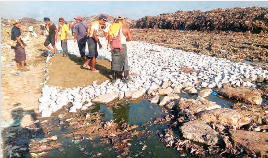
ထိန်ပင်အမှိုက်ပုံဧရိယာအတွင်း ကျောက်သားလမ်းခင်းရန် ဆောင်ရွက်နေစဉ်။
