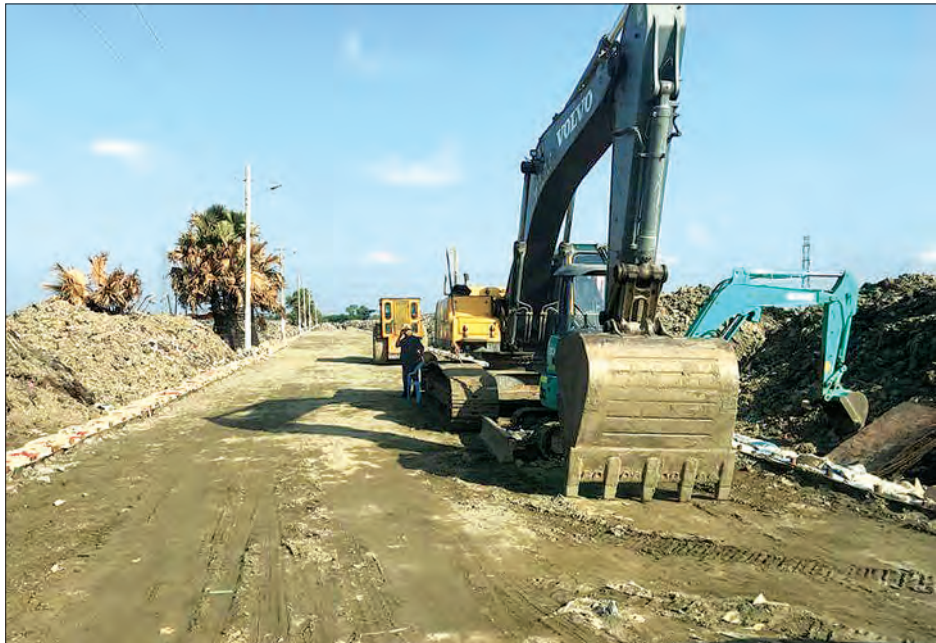
ထိန်ပင်အမှိုက်ပုံဧရိယာအတွင်း စက်ယန္တရားများအသုံးပြုပြီး ကွန်ကရစ်လမ်းခင်းရန် ဆောင်ရွက်နေမှုကို တွေ့ရစဉ်။
