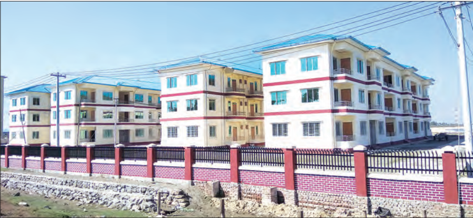
စစ်တွေမြို့၌ တည်ဆောက်ပြီးစီးသွားသည့် အိမ်ရာတိုက်ခန်းများကို တွေ့ရစဉ်။
