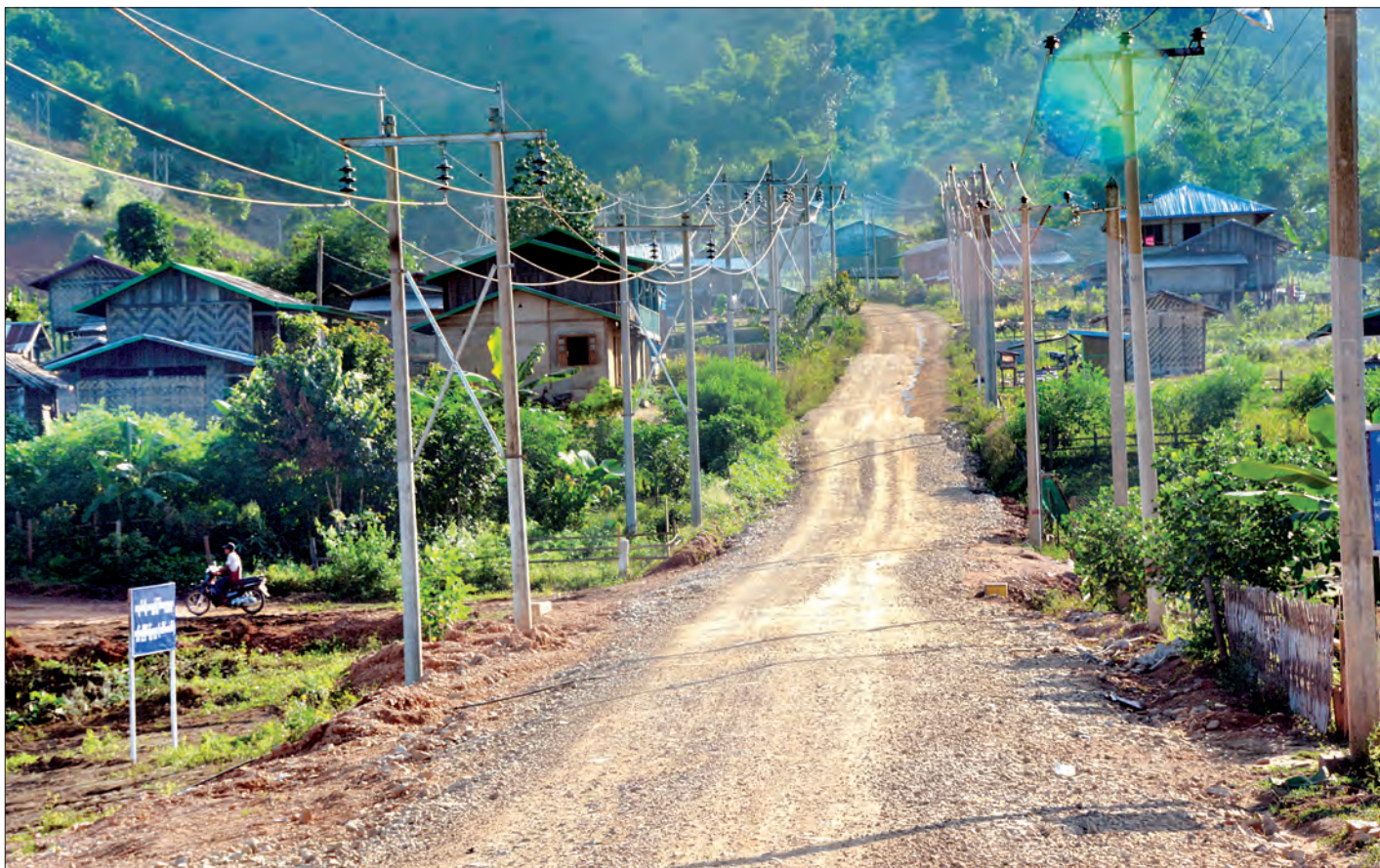
ပင်လောင်းမြို့နယ်ရှိ ကျေးရွာတစ်ရွာ၌ ကျေးရွာမီးလင်းရေးဆောင်ရွက်ထားမှုကို တွေ့ရစဉ်
