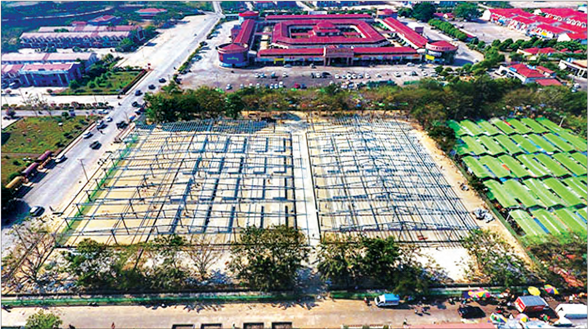
နေပြည်တော်ရှိ သပြေကုန်းဈေး အဆင့်မြင့်တင်ဆောင်ရွက်နေမှုကို တွေ့ရစဉ်
