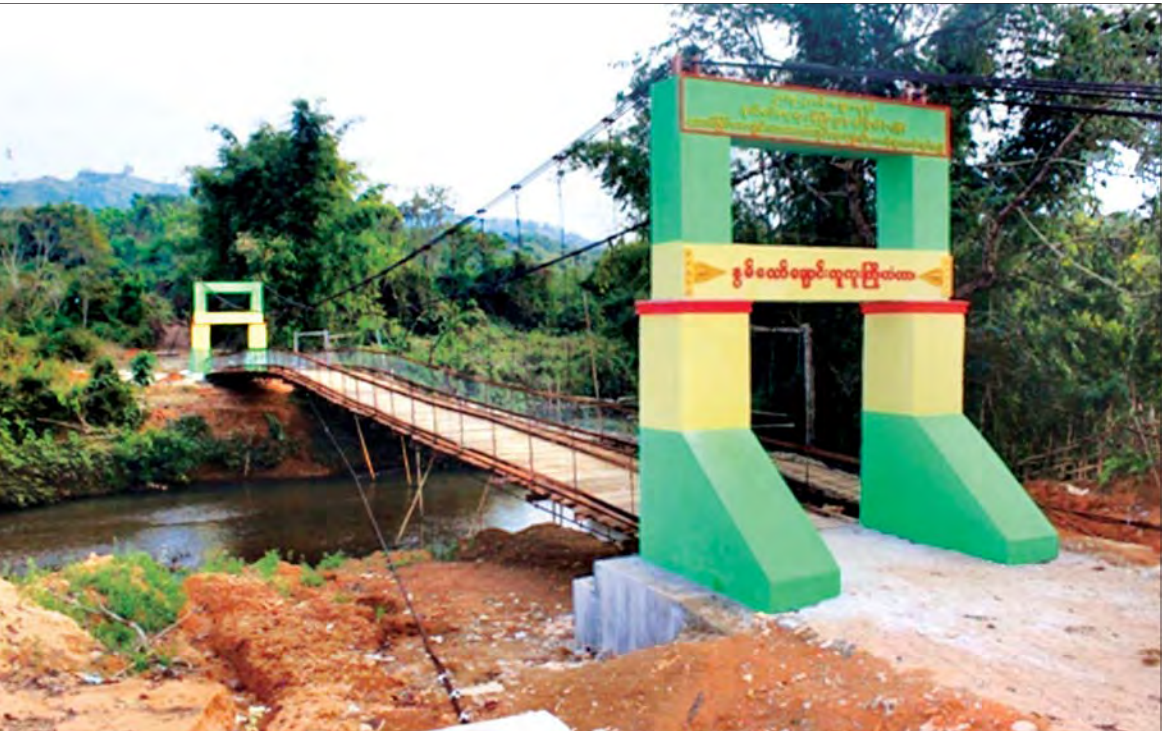
နယ်စပ်ရေးရာဝန်ကြီးဌာနမှ နယ်စပ်ဒေသသွားလာမှုလွယ်ကူစေရန် ကချင်ပြည်နယ် နွမ်လော်ချောင်း လူကူးကြိုးတံတားတည်ဆောက်ထားမှုကို တွေ့ရစဉ်။
