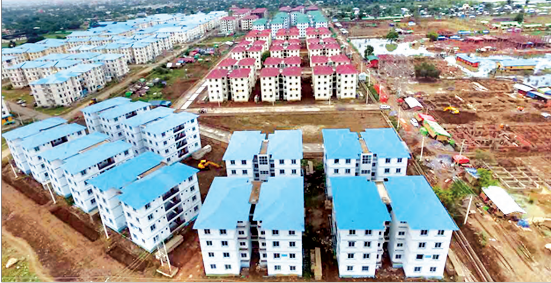
မန္တလေးမြို့ရှိ မြရည်နန္ဒာအိမ်ရာစီမံကိန်း တည်ဆောက်ပြီးစီးမှု အခြေအနေကို တွေ့ရစဉ်
