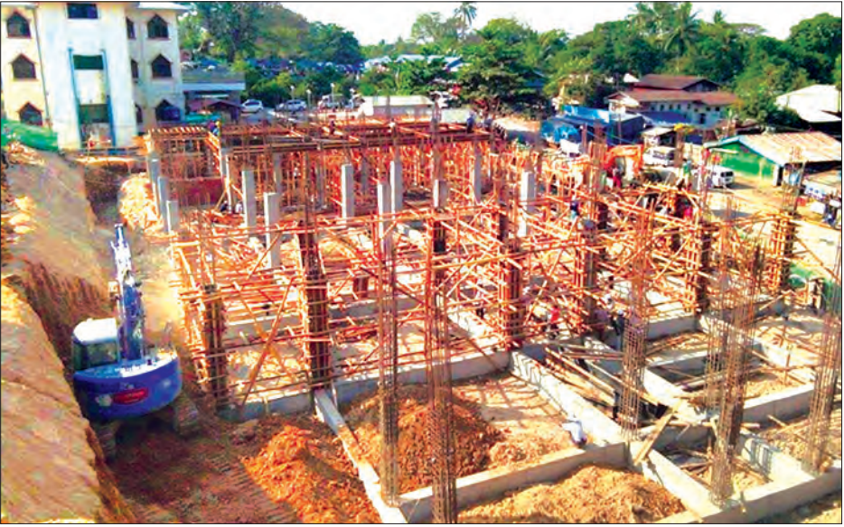
မော်လမြိုင် မိခင်နှင့် ကလေးဆေးရုံ တိုးချဲ့လှူဒါန်းဆောင် (၅)ထပ်အဆောက်အအုံ ဆောက်လုပ်နေမှုကို တွေ့ရစဉ်
