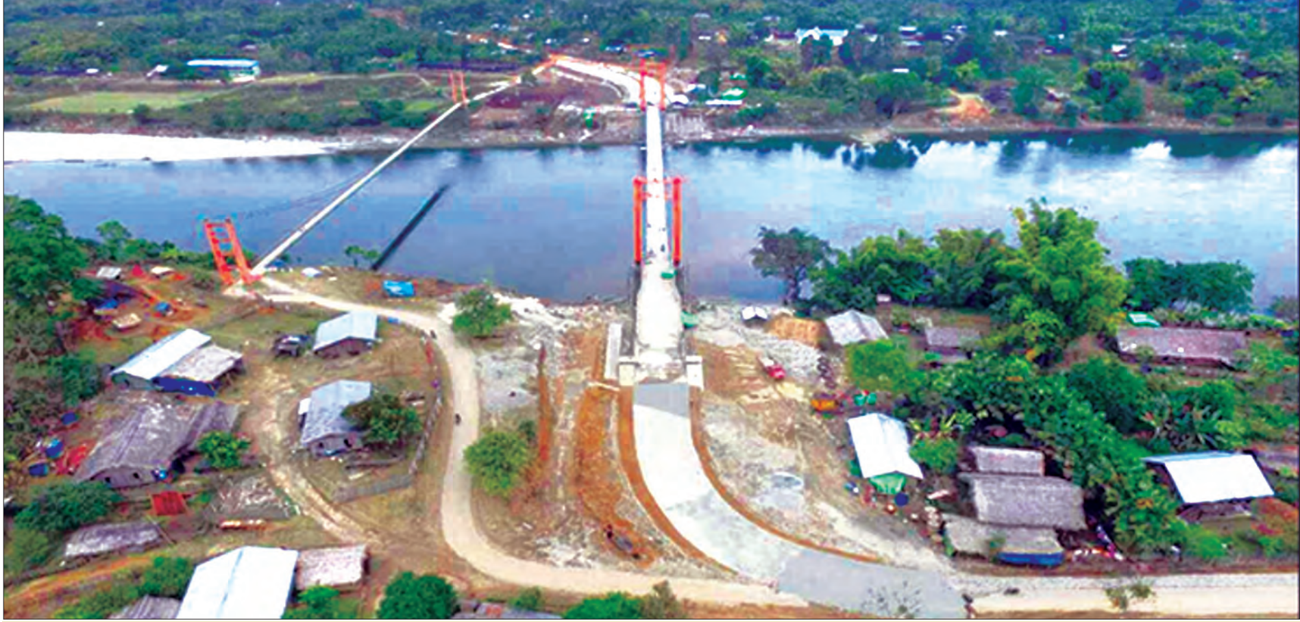
မချမ်းဘော့-ဇရုခ-နောင်မွန်လမ်းပေါ်ရှိ မချမ်းဘော့တံတားဆောင်ရွက်ပြီးစီးမှုအခြေအနေကို တွေ့ရစဉ်
