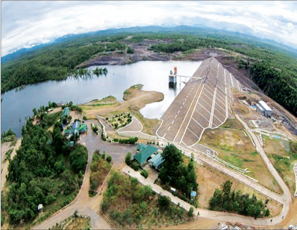
မြစ်သာရှိ ၄၀ မဂ္ဂါဝပ် ရေအားလျှပ်စစ်ဓာတ်အားပေးစက်ရုံ တည်ဆောက်ထားမှုကို တွေ့ရစဉ်။
