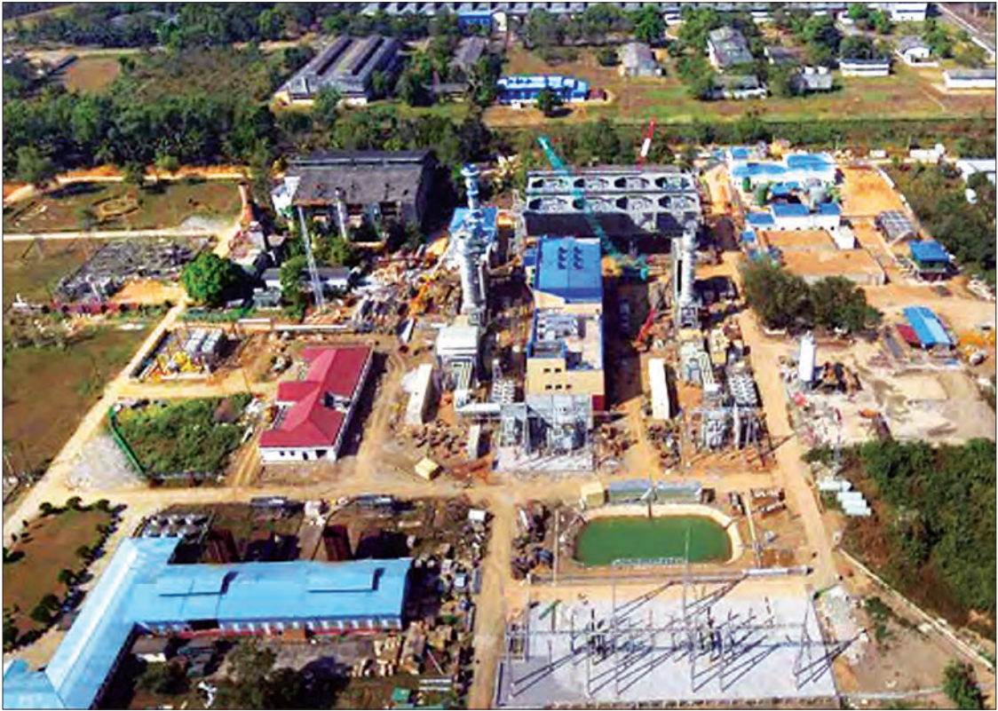
မွန်ပြည်နယ် သထုံမြို့ရှိ ၁၁၈ ဒသမ ၉ မဂ္ဂါဝပ် သဘာဝဓာတ်ငွေ့သုံး ဓာတ်အားပေးစက်ရုံ တည်ဆောက်ထားမှုကို တွေ့ရစဉ်။
