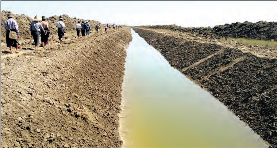
ပင်လယ်ဝအထိ တူးဖော်ရေးလုပ်ငန်း ဆောင်ရွက်နေသည့် မရမ်းကုန်းရေတံခါးတူးမြောင်းကို တွေ့ရစဉ်။
