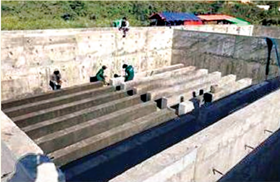
ပြင်ဦးလွင်မြို့၊ ဂါလန် ၃၀၀၀၀ ဆုံ ရေစစ်ကန်နှင့် ဂါလန် ၁၅၀၀၀ ဆုံ ရေစုကန်တည်ဆောက်နေစဉ်
