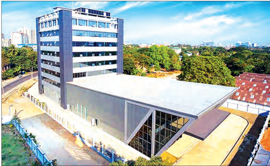
မြန်မာနိုင်ငံ အင်ဂျင်နီယာကောင်စီရုံးအဆောက်အအုံသစ်ကို တွေ့ရစဉ်
