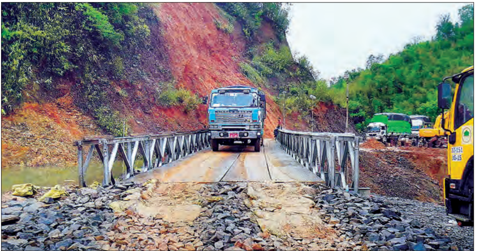
ရန်ကုန်-အမ်း-စစ်တွေ ပြည်ထောင်စုလမ်းမကြီး မိုင်တိုင်(၂၈)တွင် လမ်းပခုံးပြိုကျ၍ လမ်းပိတ်သွားခဲ့ရာ ဆောက်လုပ်ရေးဝန်ကြီး ဌာနမှ ဘေလီတံတားထိုးပေးမှုကြောင့် ဇွန် ၁၇ ရက်က ယာဉ်များ ဖြတ်သန်းမောင်းနှင်မှုကို တွေ့ရစဉ်
