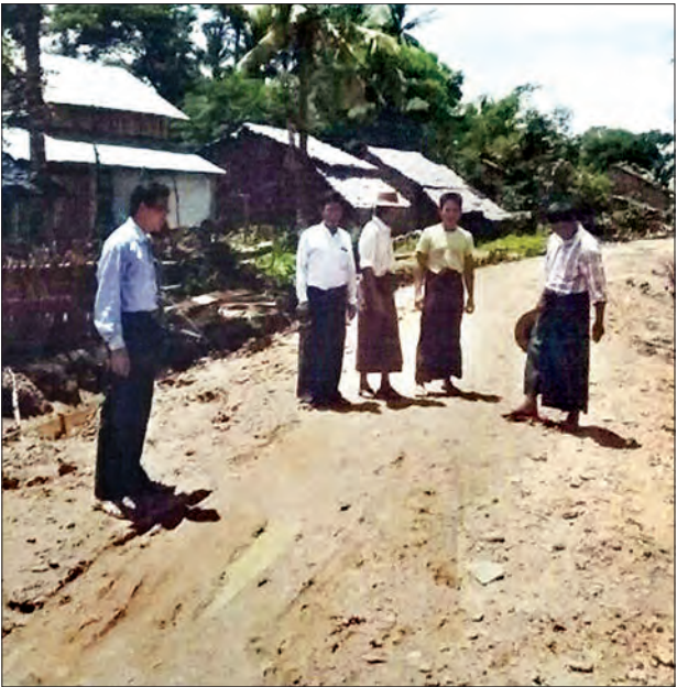
ရွှေတောင်မြို့နယ် ကျေးလက်ဒေသဖွံ့ဖြိုးတိုးတက်ရေးဦးစီးဌာန ကွင်းယားကြီးအုပ်စု ဖောင်းဖြူကျေးရွာ၌ ကျေးရွာဖွံ့ဖြိုးရေးစီမံကိန်းဖြင့် ဆောင်ရွက်သော ကျေးရွာတွင်းလမ်း မြေခံကျောက်စရစ်ခင်းခြင်းလုပ်ငန်းစတင်ဆောင်ရွက်နေစဉ်။
