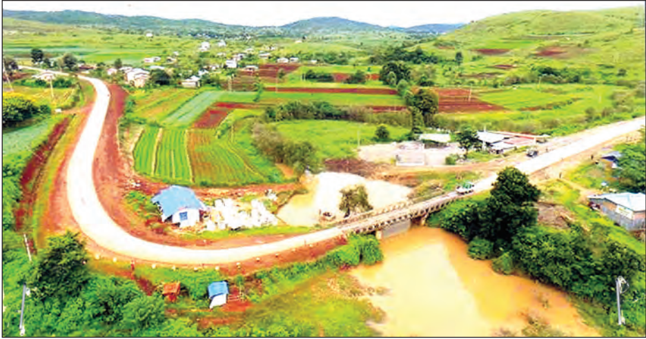
အောင်ပန်း-ပင်လောင်း-မိုးပြဲ-လွိုင်ကော် ကားလမ်းကို နန်အွန်ရွာအနီး၌ တွေ့ရစဉ်။
