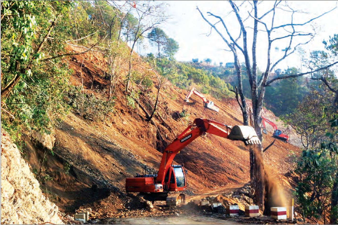
ပလက်ဝ-ကျီခါးလမ်း အဆင့်မြှင့်တင်ဆောင်ရွက်နေမှုကို တွေ့ရစဉ်
