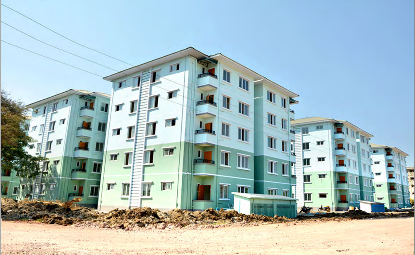
စစ်ကိုင်းတိုင်းဒေသကြီးအစိုးရအဖွဲ့စီစဉ်ကြီးကြပ်မှုဖြင့် တည်ဆောက်နေသော နန္ဒဝန်အိမ်ရာစီမံကိန်း
