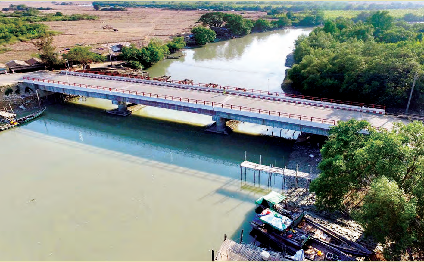
မာန်အောင်ကျွန်းပတ်လမ်းအတွင်း တည်ဆောက်ထားသည့် သံကူကွန်ကရစ် အုန်းချောင်းတံတားကို တွေ့ရစဉ်
