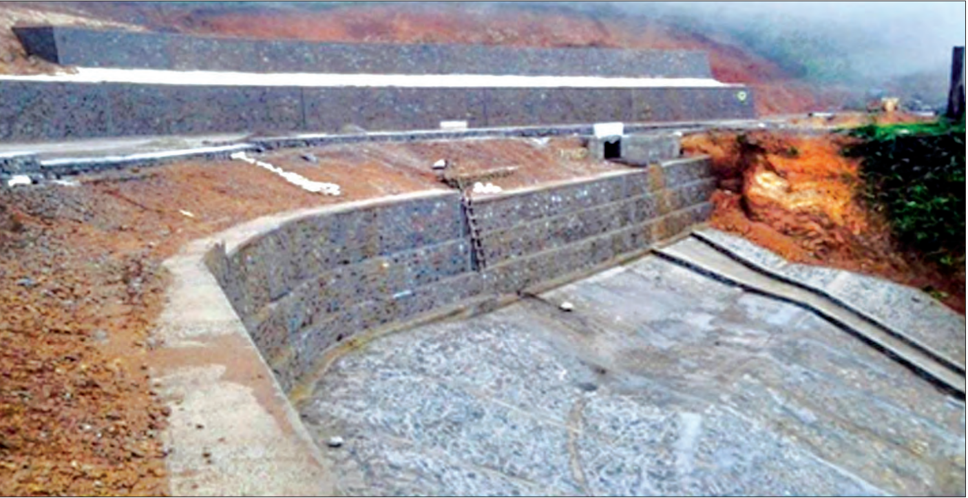
မင်းဘူး-အမ်း-စစ်တွေလမ်း ပေါ်ရှိ (၁၀၉ ဒသမ ၅ ကီလိုမီတာ-၁၁၀ ကီလိုမီတာ)အတွင်း ကျောက်စိမြေထိန်းနံရံ တည်ဆောက် ခြင်းလုပ်ငန်း ဆောင်ရွက်ပြီးစီးမှုကို တွေ့ရစဉ်
