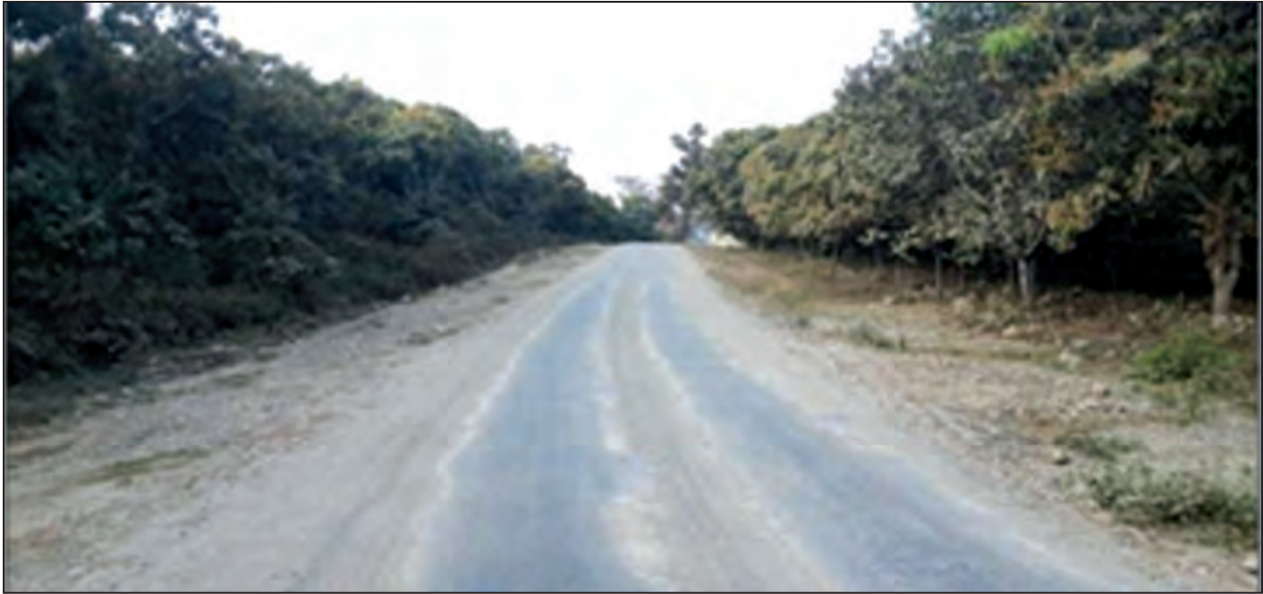
ကျောက်တော်-ပလက်ဝ လမ်းအား ကတ္တရာ လမ်းအဖြစ် အဆင့်မြှင့် တင်ခြင်း လုပ်ငန်း ဆောင်ရွက်ထားမှုကို တွေ့ရစဉ်
