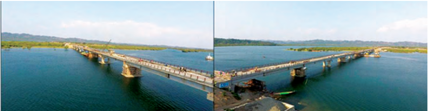
ပုဏ္ဏားကျွန်း-ရသေ့တောင်လမ်း တောဖျားချောင်းတံတား အဆင့်မြှင့်တင်ဆောင်ရွက်သည့် အရှည် ၃၆၅ ဒသမ ၇ မီတာ သံကူကွန်ကရစ်တံတား ဆောင်ရွက်ပြီးစီးမှုကို တွေ့ရစဉ်
