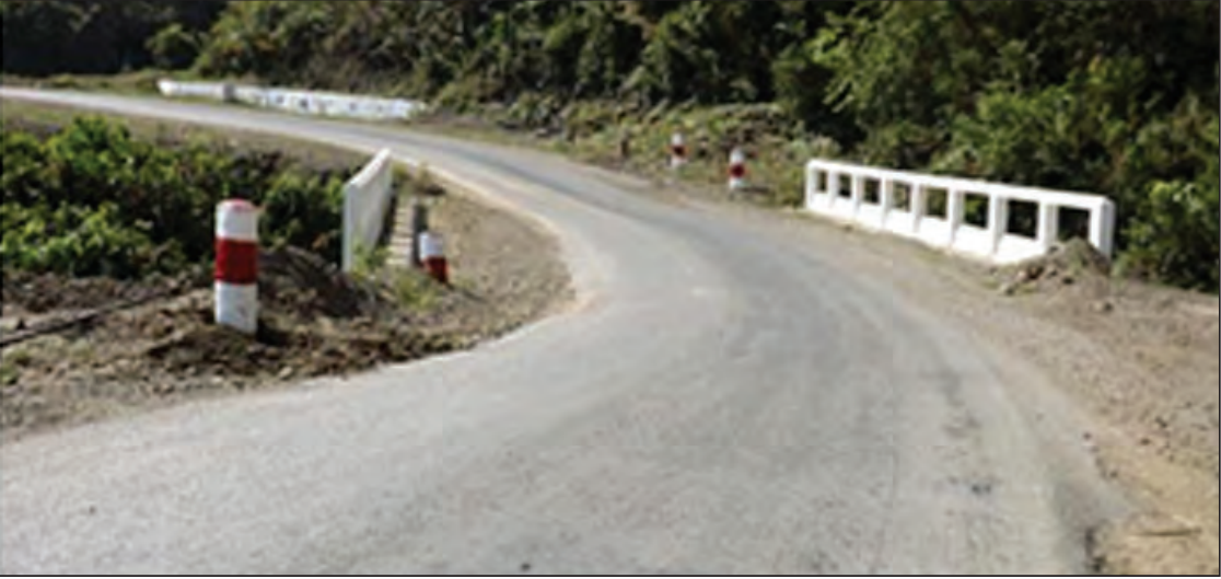
ဘူးသီးတောင်-မောင်တောလမ်း မိုင် (၆/၇.၇/၀) ကြား အရှည်ပေ ၄၀ တံတားအမှတ် (၁၃/၇) ကို သံကူကွန်ကရစ်တံတား တည်ဆောက်ခြင်း ဆောင်ရွက်ပြီးနောက် တွေ့ရပုံ
