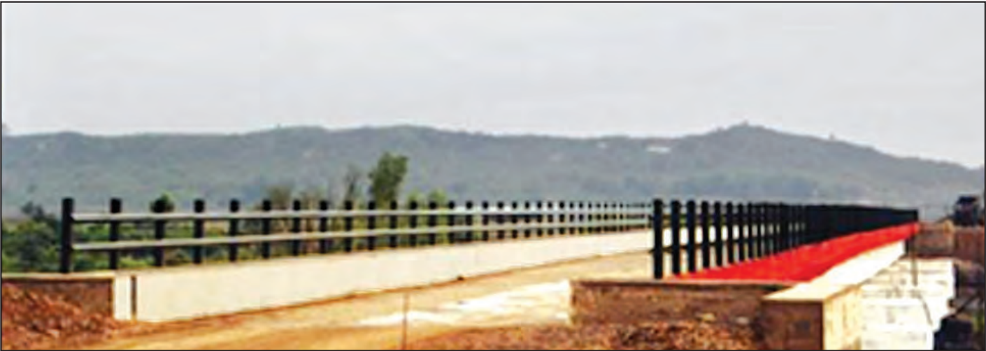
မင်းဘူး-အမ်း-စစ်တွေလမ်း မူလဘေလီ+သစ်သားတံတားမှ သံကူကွန်ကရစ်တံတားသို့ အဆင့်မြှင့်တင်ဆောင်ရွက်သည့် ကင်းချောင်းတံတား အရှည်ပေ ၄၄၀ အား ဆောင်ရွက်ပြီးနောက် တွေ့ရပုံ
