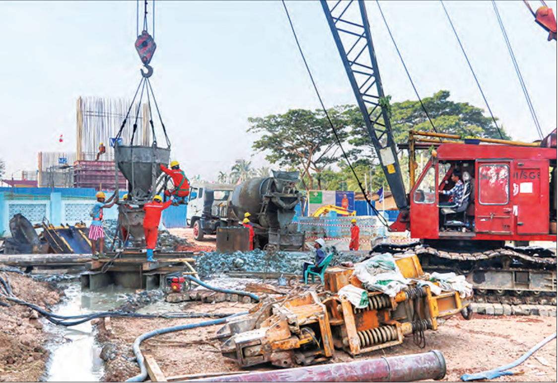
မြောင်းမြဘက်ကမ်း ပင်မတံတား တိုးပိုင် ကွန်ကရစ်လောင်းခြင်းလုပ်ငန်း ဆောင်ရွက်နေမှုကို တွေ့ရစဉ်။
