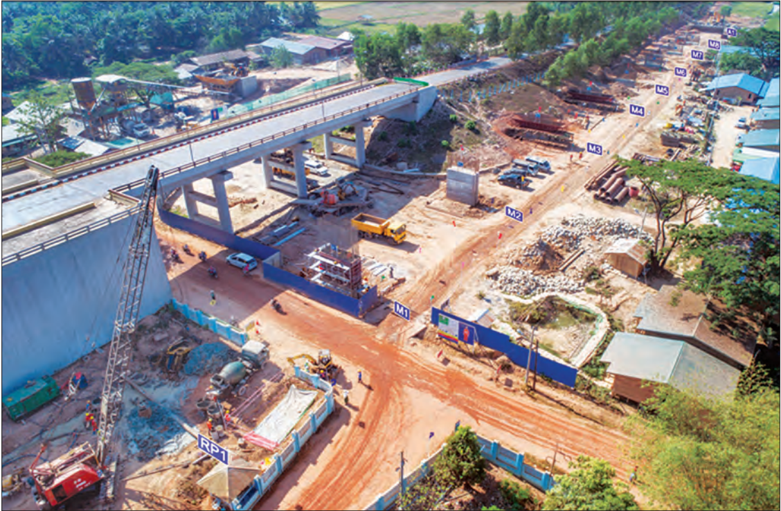
မြောင်းမြဘက်ကမ်း တံတားတည်ဆောက်ရေးလုပ်ငန်းခွင်ကို တွေ့ရစဉ်။
