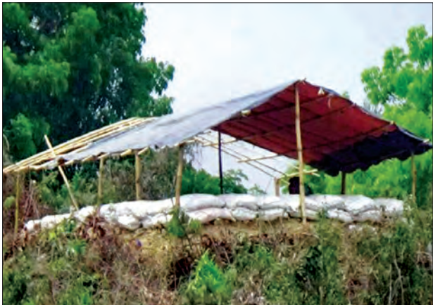
ဘင်္ဂလားဒေ့ရှ်နိုင်ငံဘက်ခြမ်း နှစ်နိုင်ငံနယ်နိမိတ်မျဉ်းနှင့် ခန့်မှန်း ၃၅ ပေခန့်အကွာ နေရာတွင် သဲအိတ်၊ မြေသား အိုဗာဟက်ပစ်ကျင်းတည်ဆောက်ထားမှုကို တွေ့ရစဉ်။
