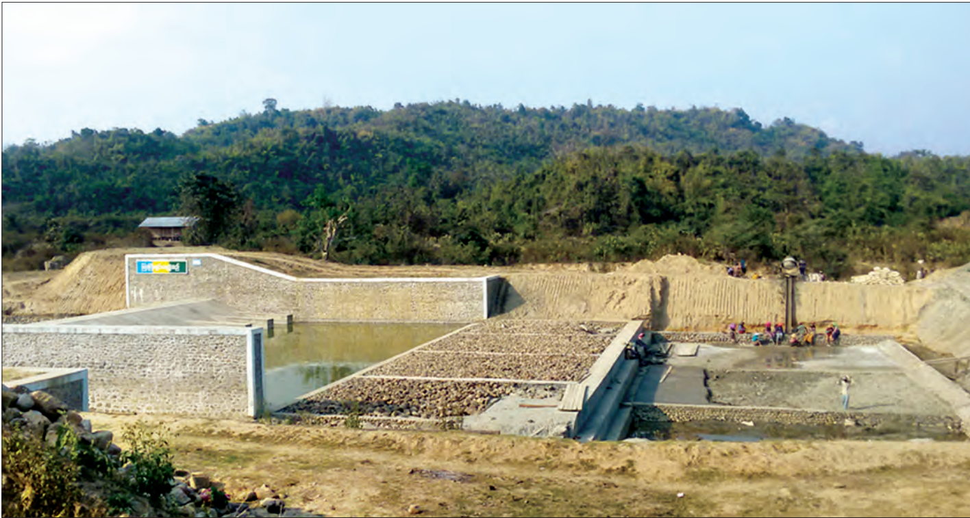
မိုးညှင်းမြို့ကြားကြီးကွင်းရေလွှဲဆည် တည်ဆောက်ခြင်းလုပ်ငန်း
