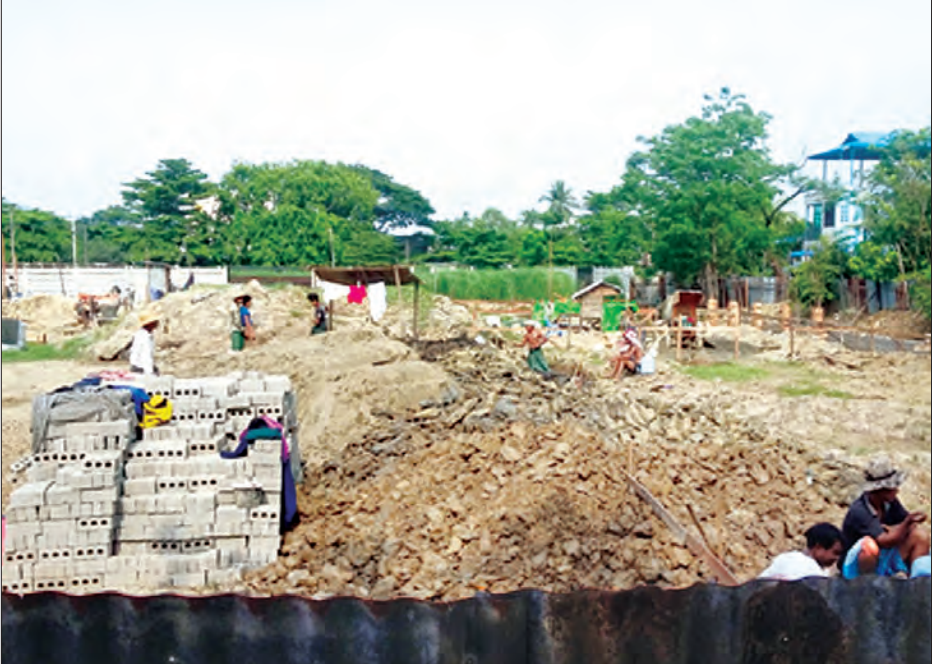
လိုင်သာယာမြို့နယ် အမှတ်(၈)ရပ်ကွက်ပြည်သူများကန့်ကွက်ထားသည့် ဓာတ်ဆီဆိုင်ဆောက်လုပ်မည့်နေရာ၌ မြေတူးဖော်ဆောင်ရွက်ထားမှုကို တွေ့ရစဉ်
