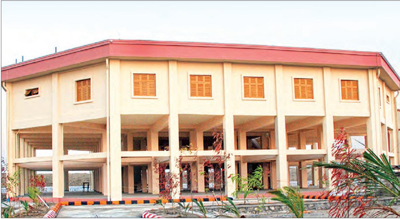
ဧရာဝတီတိုင်း၌ ဆောက်လုပ်ထားသည့် မုန်တိုင်းဒဏ်ခံအဆောက်အအုံတစ်လုံးကို တွေ့ရစဉ်။
