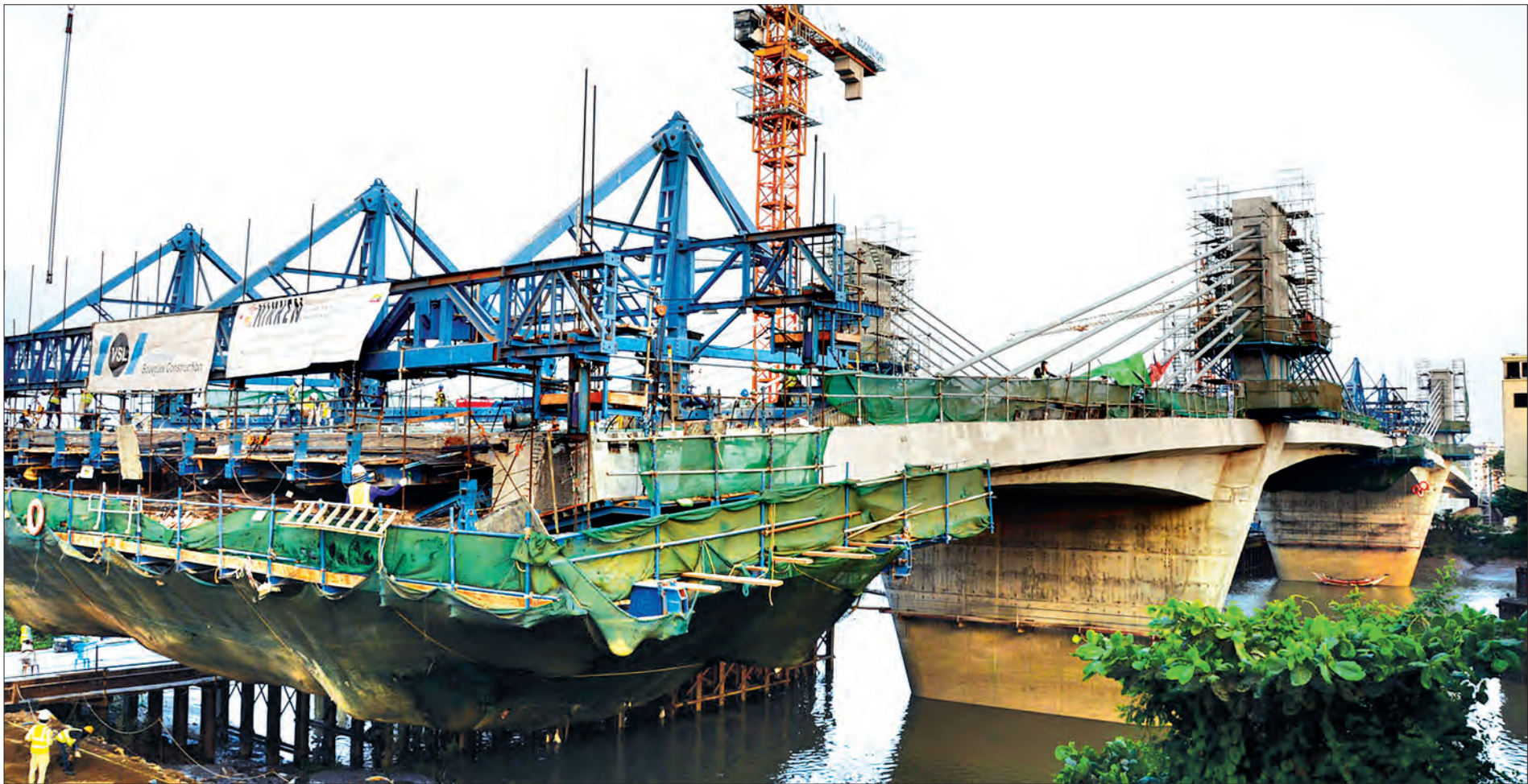
သာကေတတံတားသစ်ကြီး တည်ဆောက်မှုလုပ်ငန်းခွင်တစ်နေရာကို တွေ့ရစဉ်။
