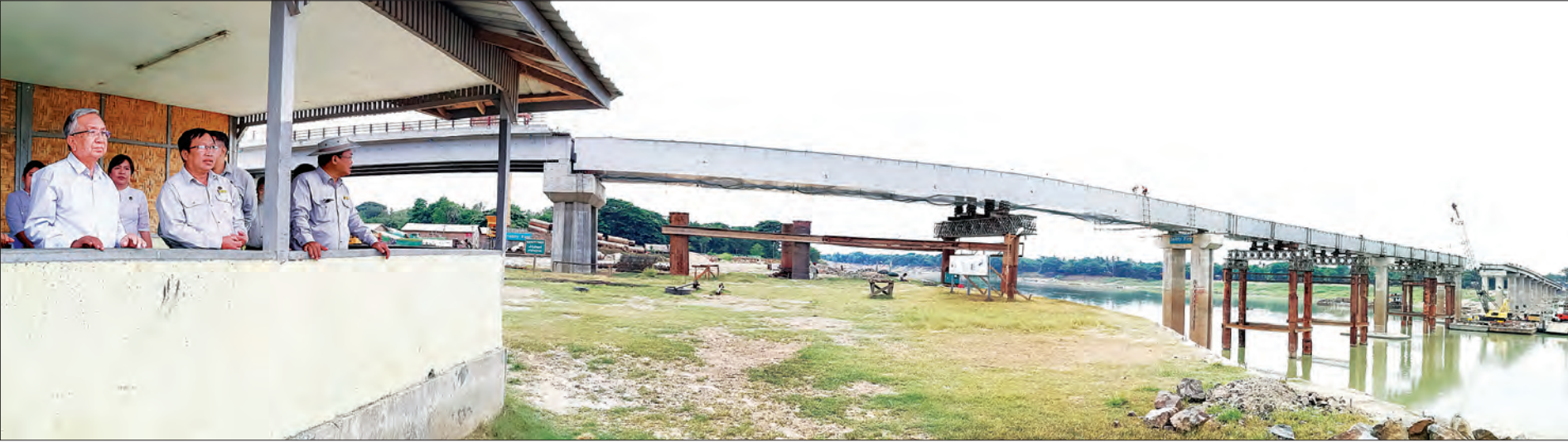
ပြည်ထောင်စုဝန်ကြီး ဦးဟန်ဇော် ငဝန်တံတား(လေးမျက်နှာ) တည်ဆောက်နေမှု အခြေအနေကို ကြည့်ရှုစစ်ဆေးစဉ်။ သတင်းစဉ်
