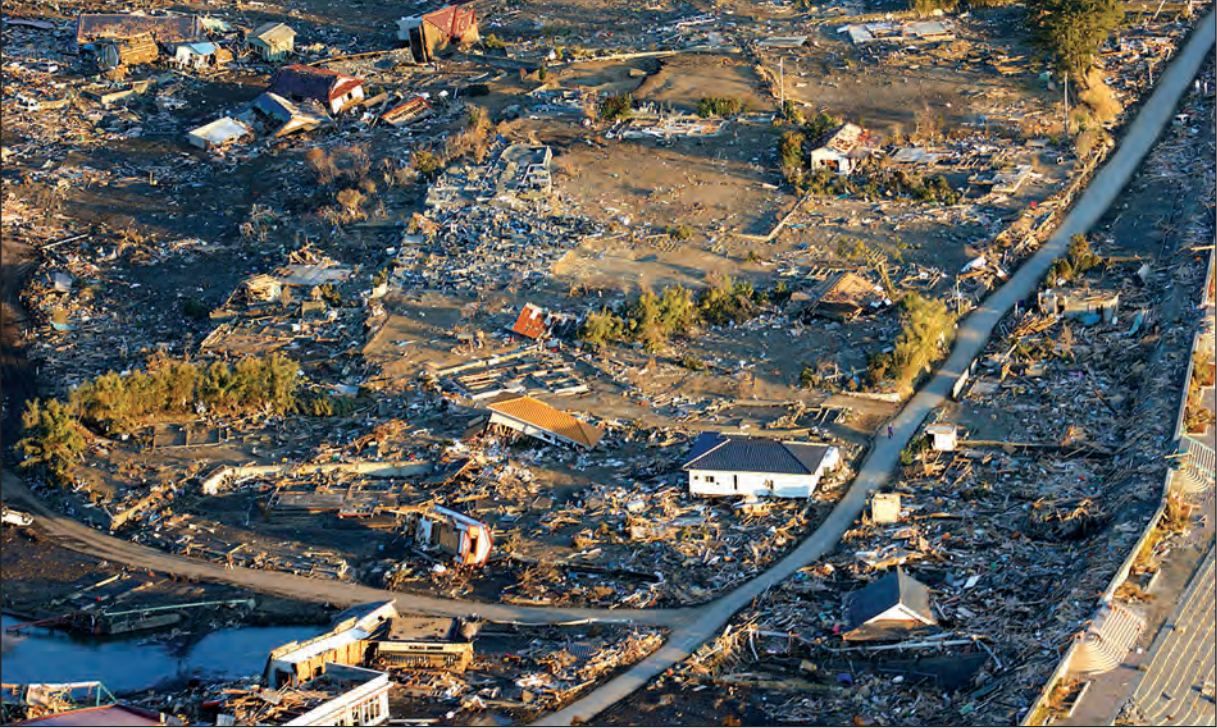
၂၀၁၁ ခုနှစ်က ဂျပန်နိုင်ငံတွင် ဆူနာမီရေလှိုင်းများကြောင့် ပျက်စီးခဲ့သည့်အဆောက်အအုံများကို တွေ့ရစဉ်။ (ဓာတ်ပုံ-ဝီကီပီးဒီးယား)
