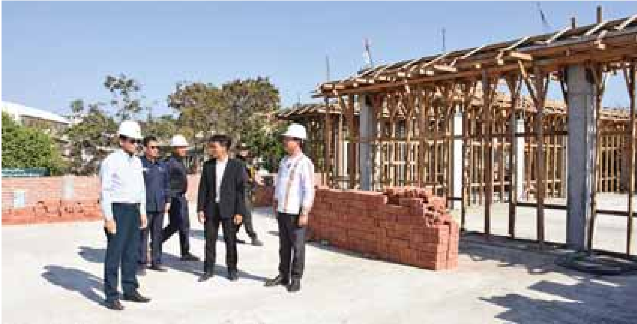
ဒုတိယသမ္မတ ဦးဟင်နရီဗန်ထီးယူ မင်းတပ် မြို့မဈေးသစ် တည်ဆောက်နေမှုကို ကြည့်ရှုစစ်ဆေးစဉ်။
