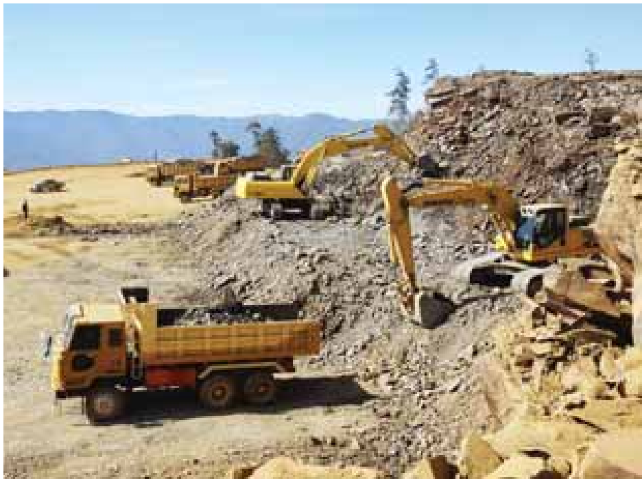
ဖလမ်းလေယာဉ်ကွင်း(ဆူရ်ဘုန်)တည်ဆောက်ရေးစီမံကိန်းကို တွေ့ရစဉ်။
