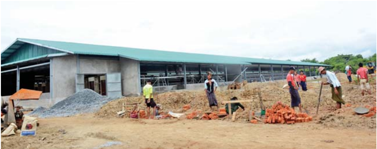
ခေတ်မီဥစားကြက်ခြံ ဆောက်လုပ်နေမှုကို တွေ့ရစဉ်။
