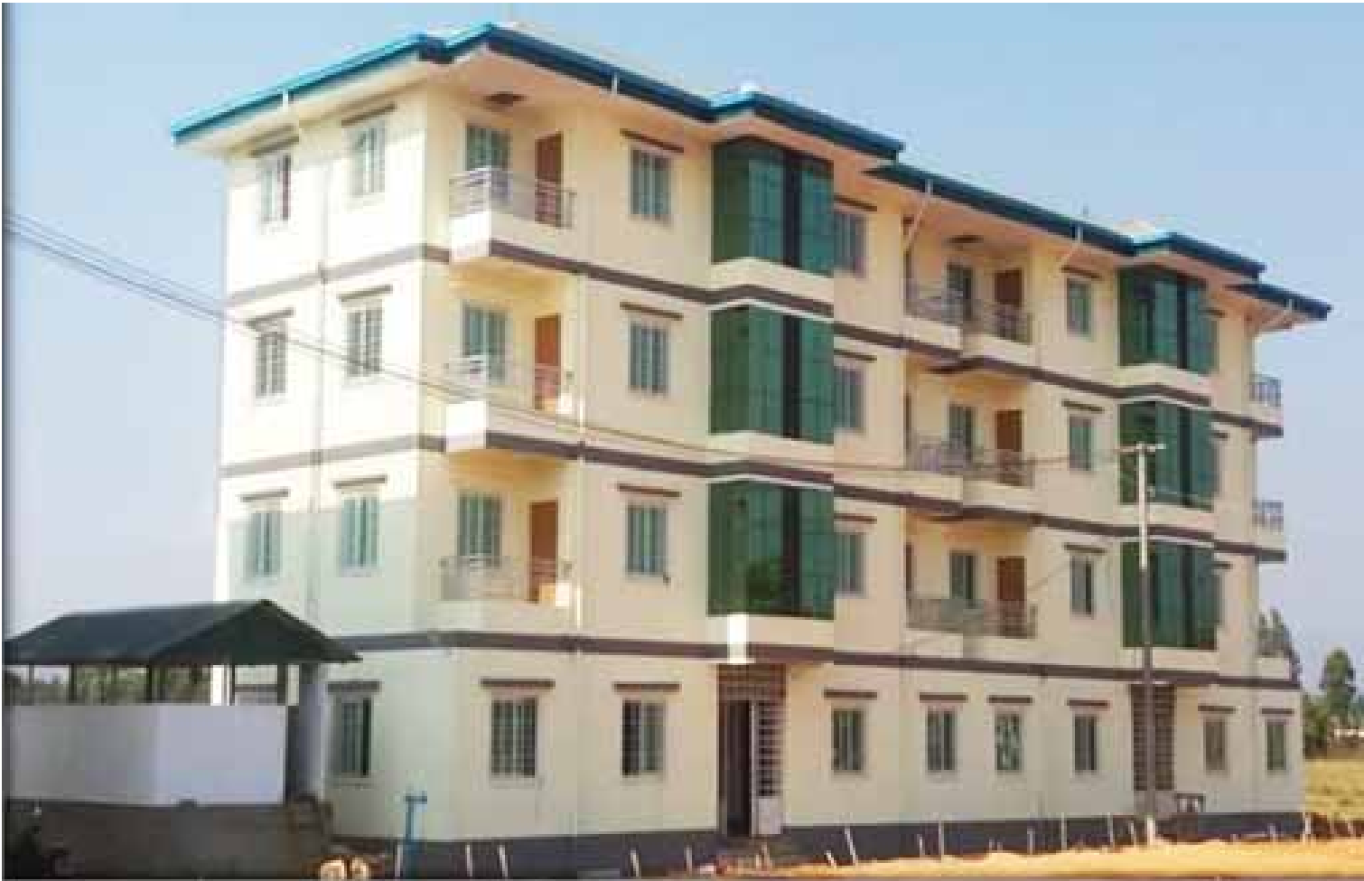
ကျိုက်ထိုမြို့နယ်တွင် တည်ဆောက်ပေးထားသော ဝန်ထမ်းအိမ်ရာများကို တွေ့ရစဉ်။
