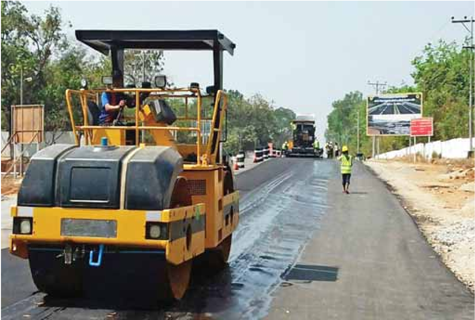
ကျိုက်တုံ-ကင်မွန်းစခန်းလမ်းအား စက်ယန္တရားကြီးများဖြင့် လမ်းခင်းခြင်းလုပ်ငန်း ဆောင်ရွက်နေမှုကို တွေ့ရစဉ်။
