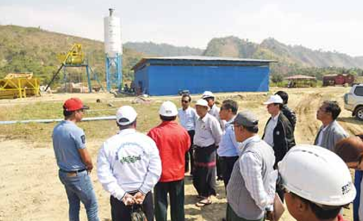
ပြည်နယ်ဝန်ကြီးများနှင့်အဖွဲ့ အမှုဆောင်-မောင်တောလမ်းဆောင်ရွက်နိုင်ရန် Batching Plant ကွန်ကရစ်ဖျော်သည့်လုပ်ငန်းခွင်ကို ကြည့်ရှုစစ်ဆေးကြစဉ်။
