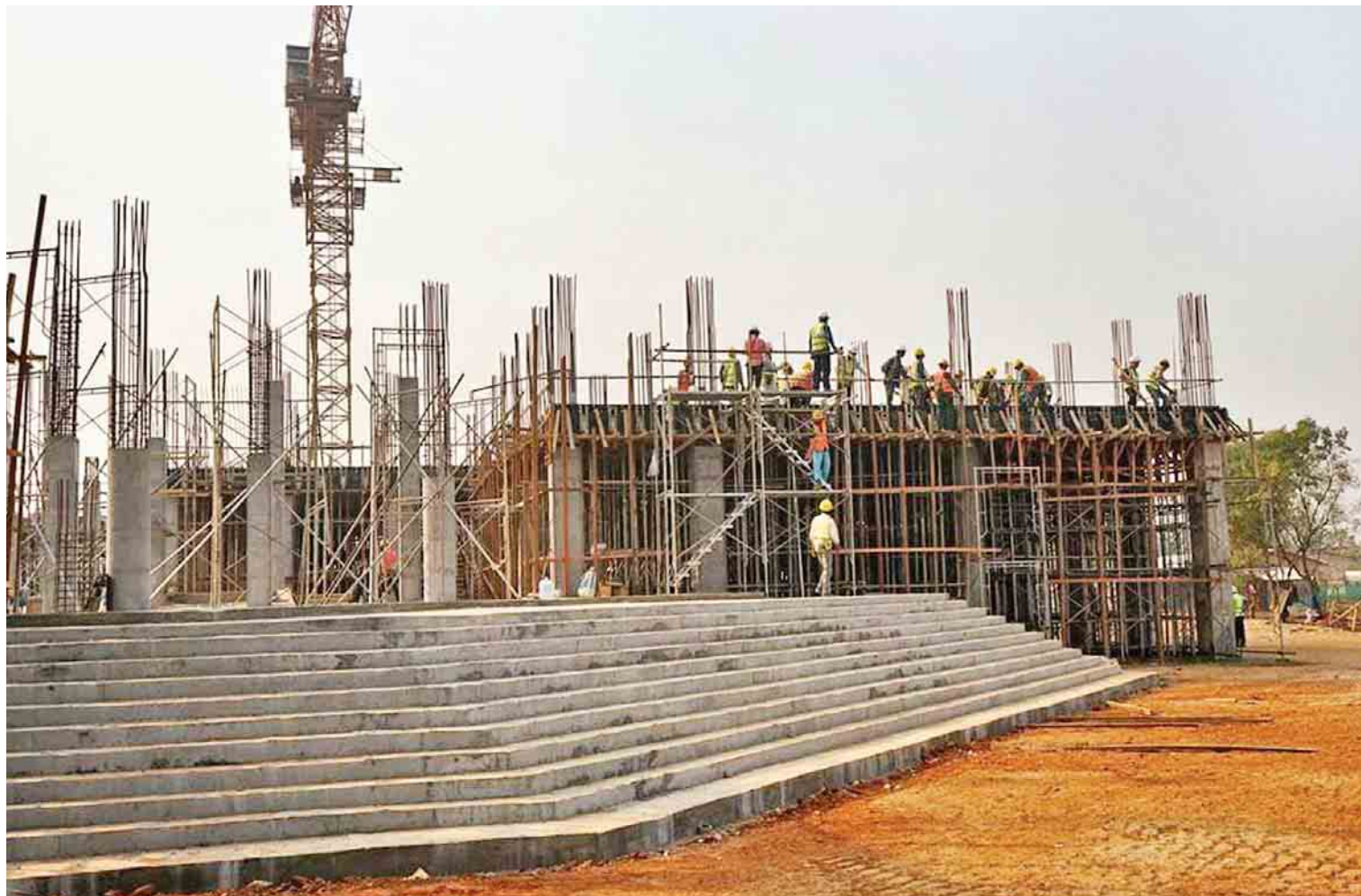
မကွေးတိုင်းဒေသကြီး လွှတ်တော်တည်ဆောက်ရေးလုပ်ငန်းခွင်ကို တွေ့ရစဉ်။
