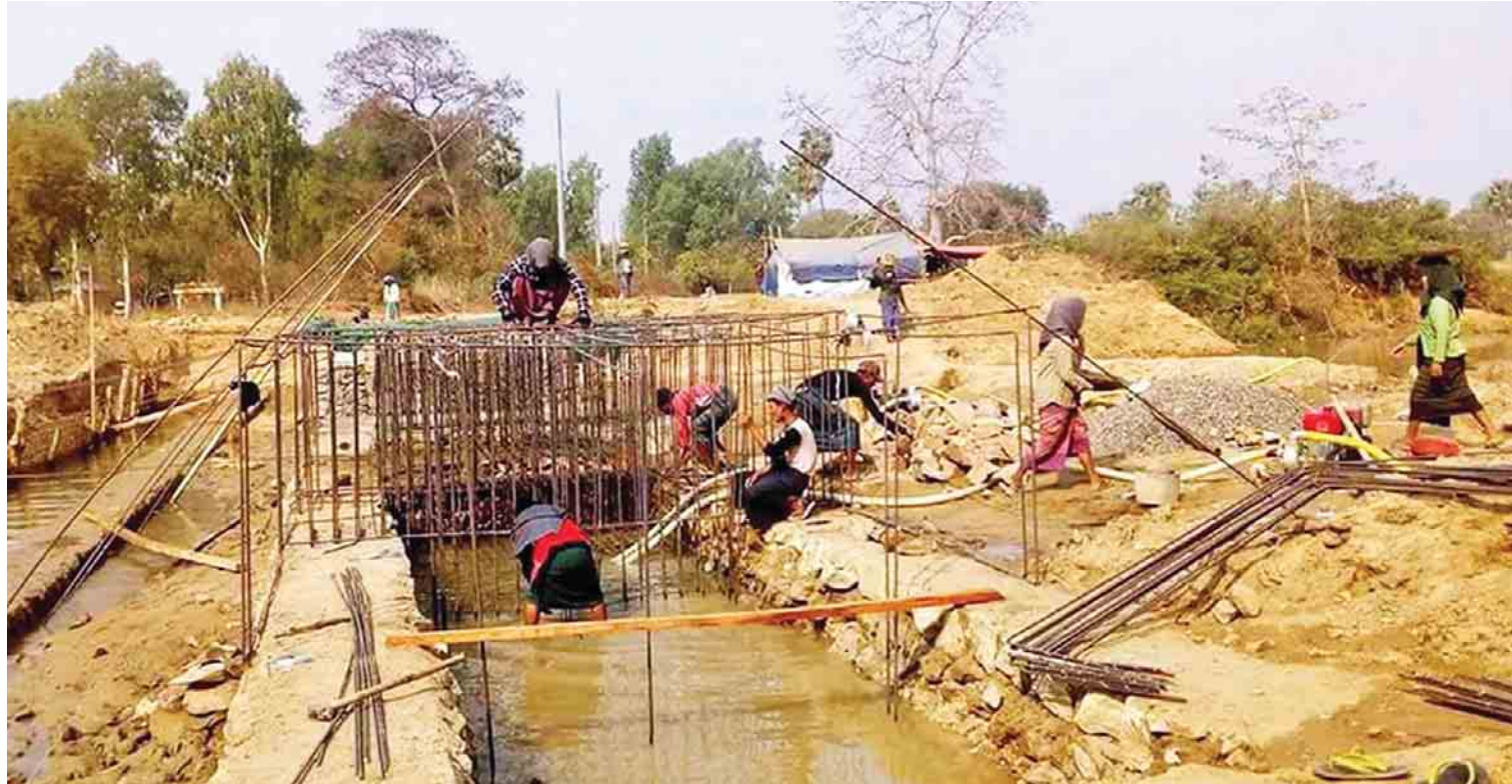
မကွေးတိုင်းဒေသကြီး နတ်မောက်မြို့နယ် လေးအိမ်ကျေးရွာ အထက်တန်းကျောင်းခွဲ ရေကျော်တံတားတည်ဆောက်နေမှုကို တွေ့ရစဉ်။
